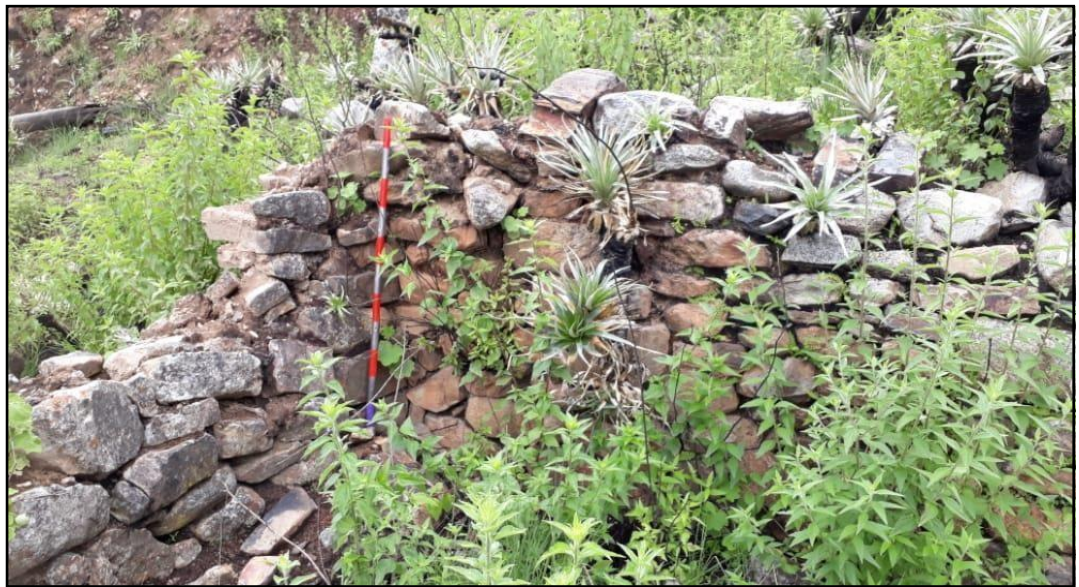
Vista de detalle de un patrón de muro Wari. Sector A
