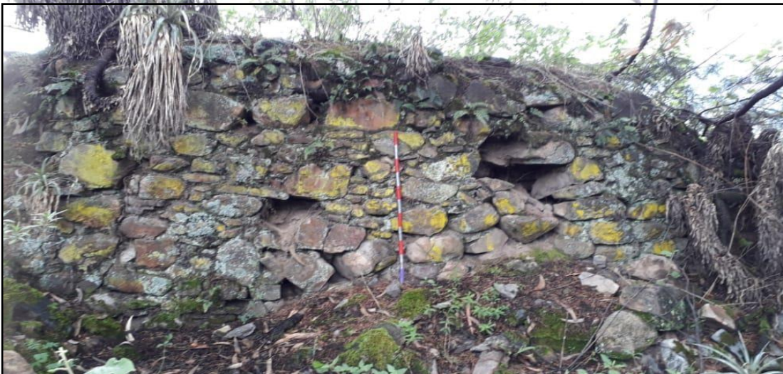
Vista de detalle de la estructura del muro defensivo más conservada con piedra canteada y piedras angulosos y con revestimiento de argamasa de barro. Sector A
