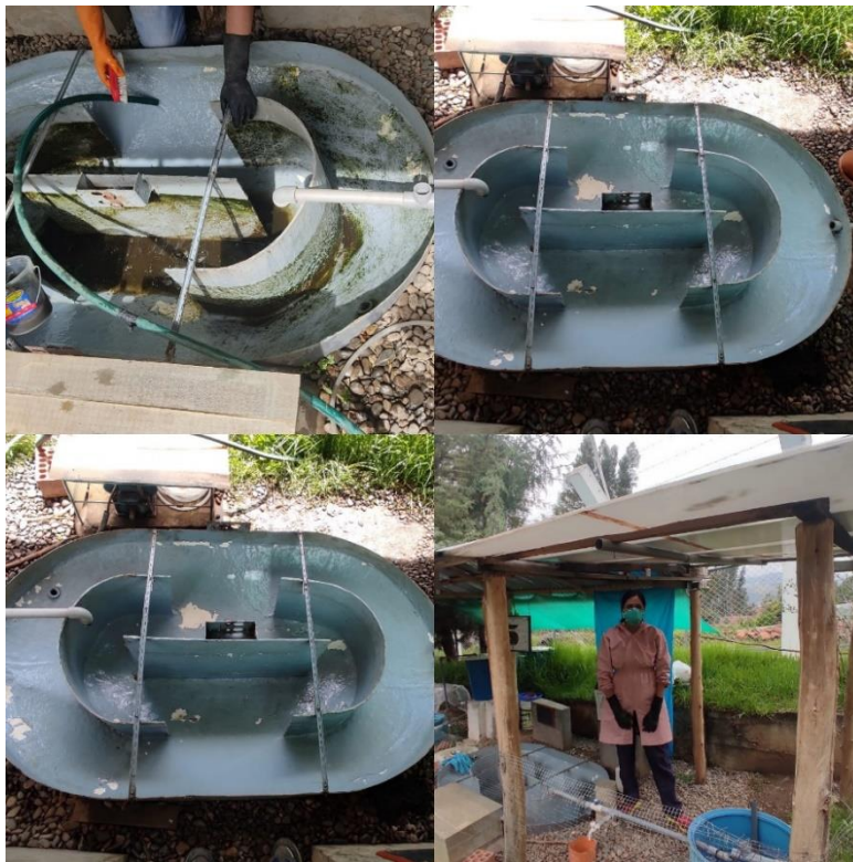
Foto 13: Limpieza de la Zanja de Oxidación
