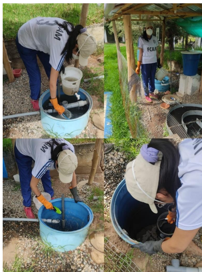
Foto 12: Limpieza del Sedimentador Primario Circular
