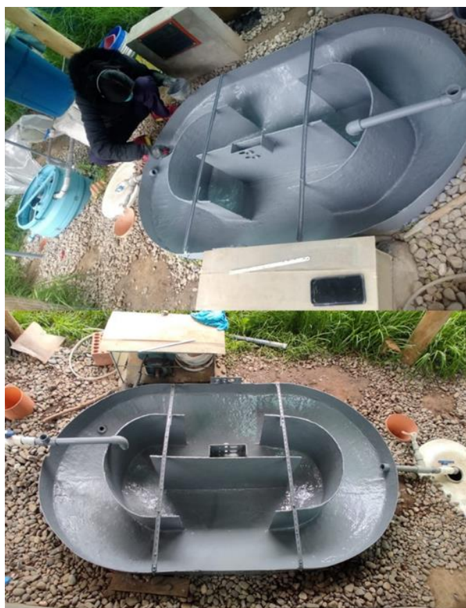
Foto 16: Pintado de la Zanja de Oxidación
