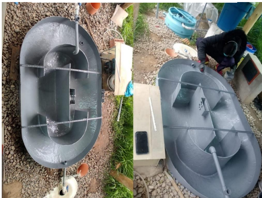
Foto 5: Pintado de la Zanja de Oxidación
