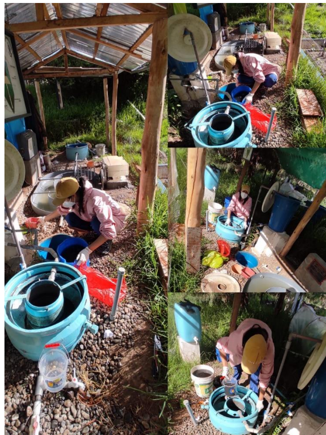
Foto 14: Limpieza del Pre Sedimentador y Sedimentador Circular
