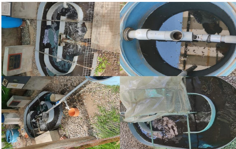
Foto 12: Limpieza del Sedimentador Primario Circular
