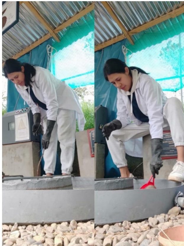
Foto 29: Mantenimiento y Limpieza de la Zanja de Oxidación-Adaptación
