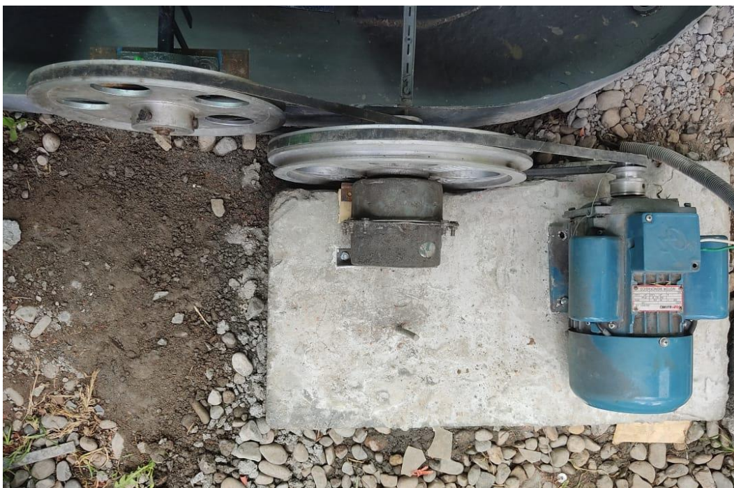
Foto 20: Instalación de Nuevas Poleas
