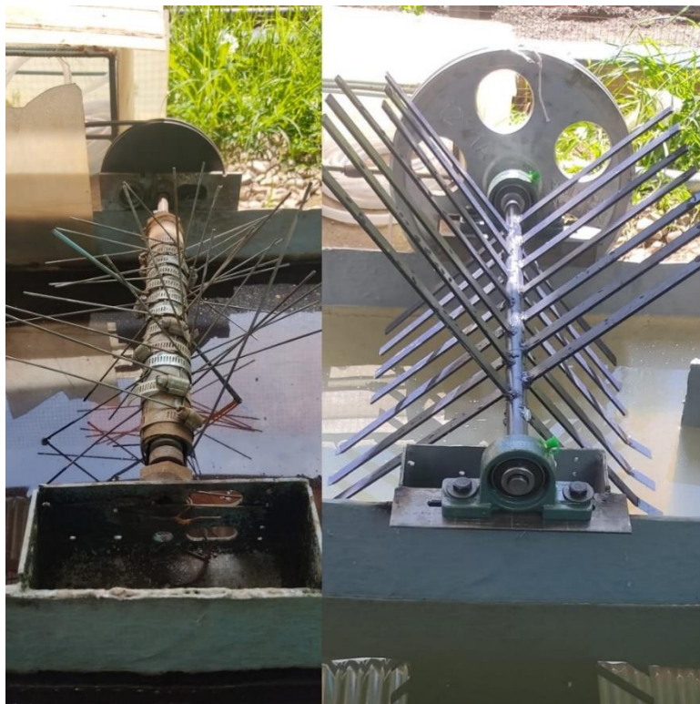
Foto 6: Cambio de Paletas del Sistema de Aireación
