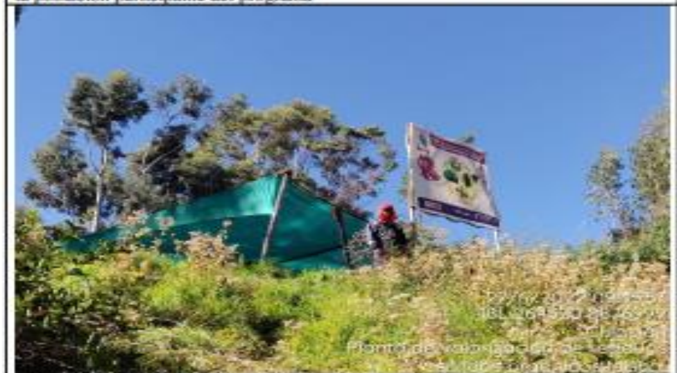
Fotografía N° 10. Vista frontal de la planta de valorización de residuos sólidos orgánicos
