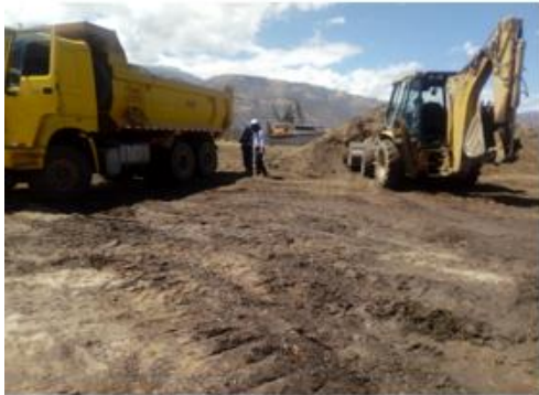
SUPERVISION DEL ESTADO DE MAQUINARIA PESADA - VOLQUETES
