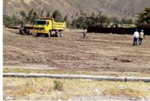
VERIFICACION DE TRABAJOS EN COORDINACION CON EL RESIDENTE DE OBRA
