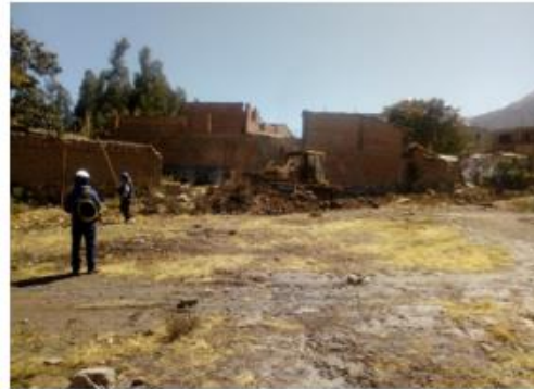
INSPECCION DE TRABAJOS – CORTE DE CAPA VEGETAL ZONA NORTE
