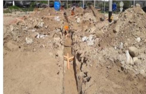
INSTALACION DE CONEXIONES DOMICILIARIAS DE ALCANTARILLADO
