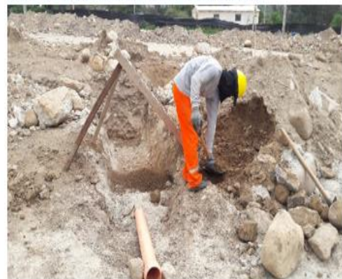
PRUEBA DE COMPACTACIÓN EN CAMPO
