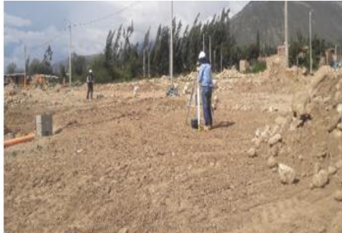
VERIFICACIÓN DE NIVELES USANDO NIVEL TOPOGRÁFICO
