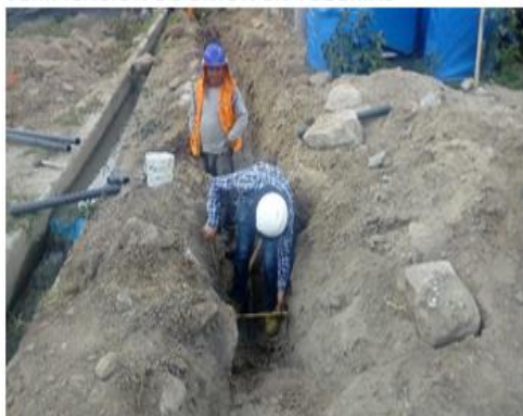
VERIFICACION DE UNION EN TUBERÍAS
