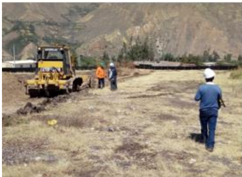
INSPECCION DE TRABAJOS – CORTE DE CAPA VEGETAL ZONA CENTRAL
