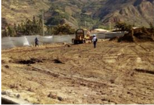
INSPECCIÓN DE CORTE CON MAQUINARIA TRACTOR ORUGA
