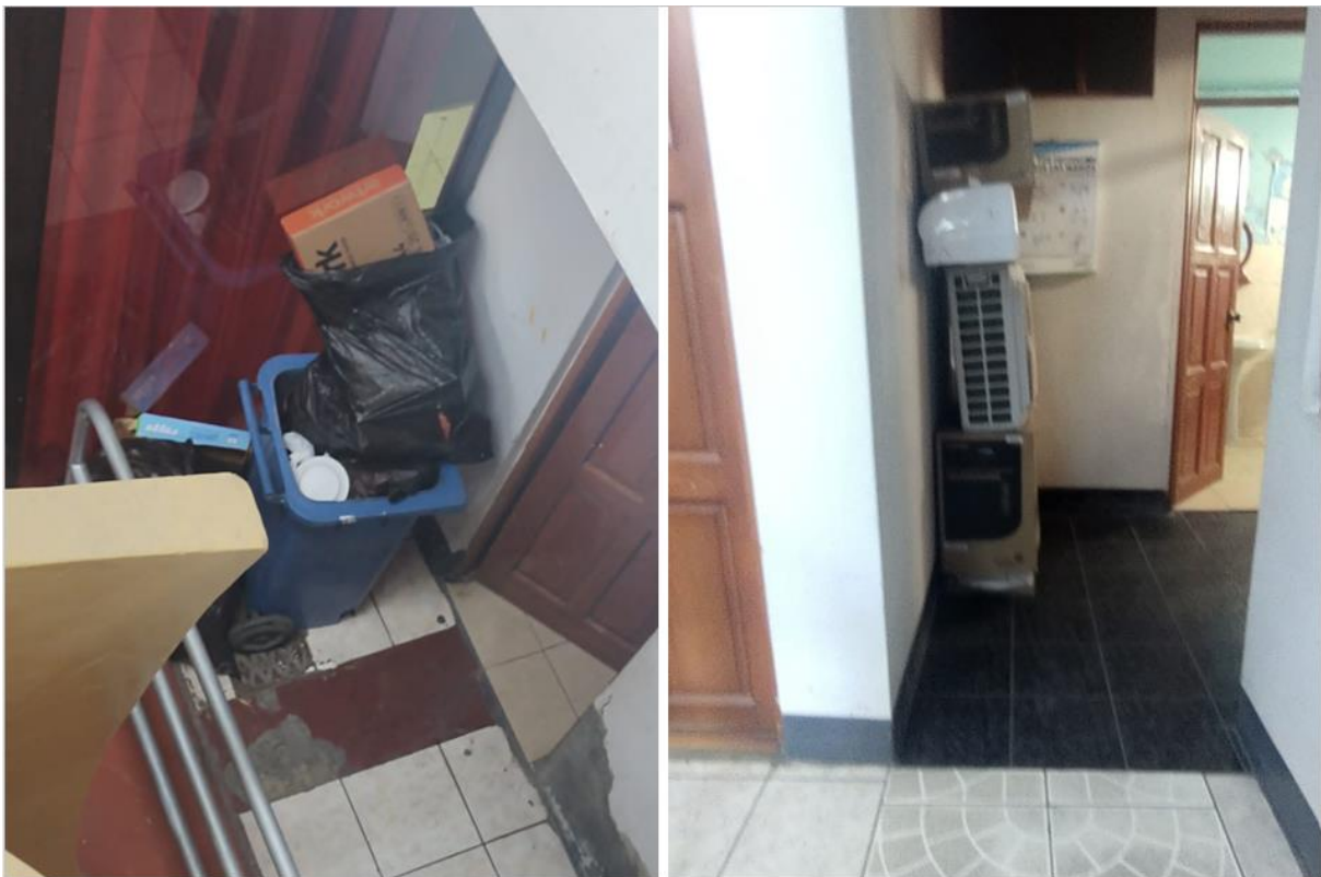
Condiciones subestándares en ingresos a SS, HH.
