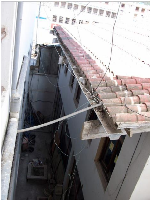
Cables eléctricos y conexiones peligrosas
