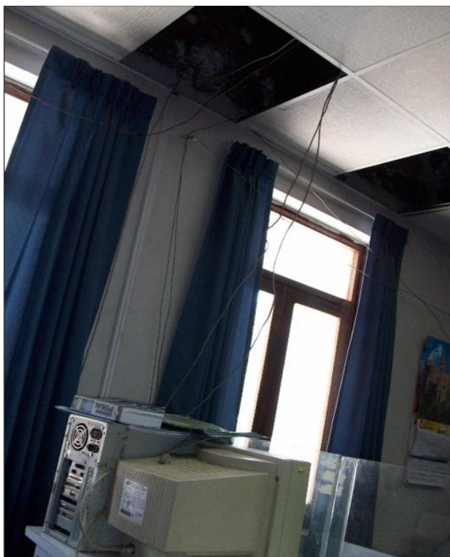
Cableado suelto y cielo raso deteriorado en oficinas
