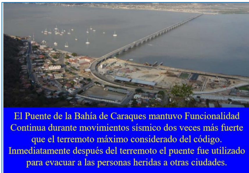
Imagen N° 24 Puente de Bahía
