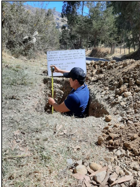
Fotografía 13: Profundidad 1.50 m calicata N°05
