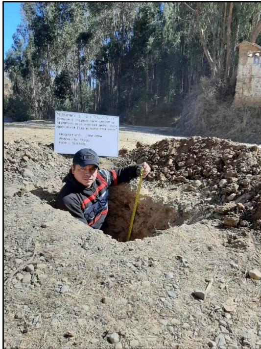
Fotografía 9: Profundidad 1.5 m de calicata N°04
