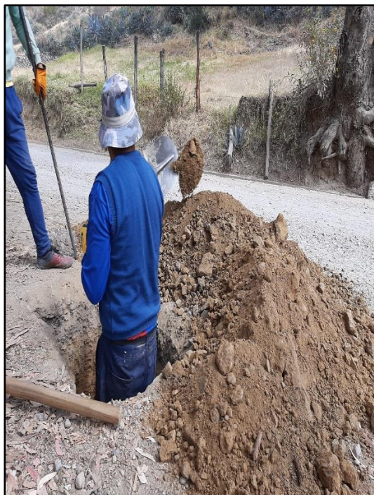
Fotografía 23: Excavación de calicata N°10
