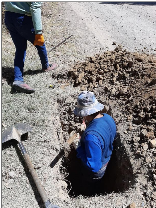
Fotografía 11: Excavación de calicata N°05
