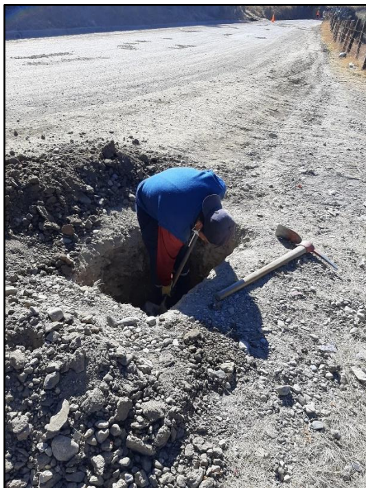
Fotografía 7: Excavación de calicata N°03
