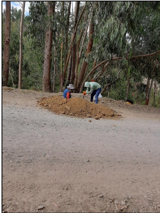
Fotografía 21: Excavación 1.50 m. Calicata N°09
