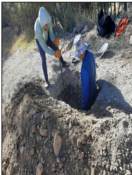
Fotografía 17: Excavación de calicata N°07
