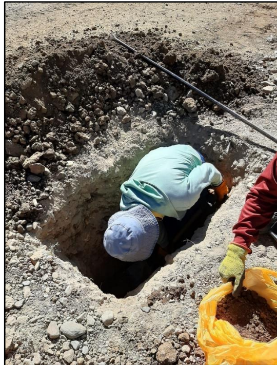
Fotografía 6: Extracción de muestra calicata N°02
