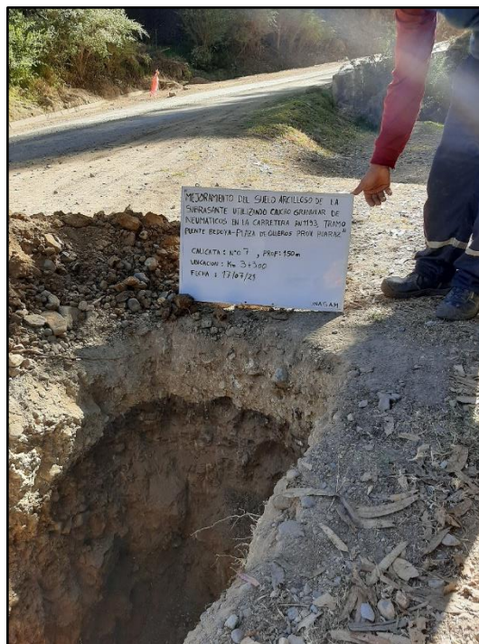
Fotografía 18: Profundidad 1.50 m. Calicata N°07
