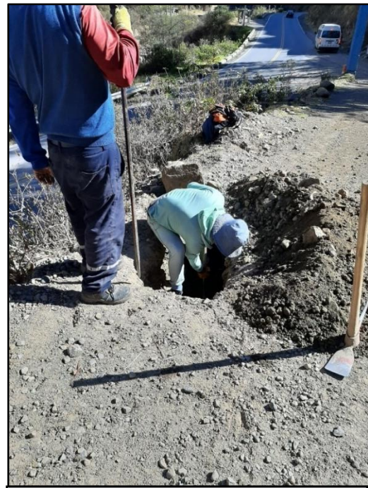
Fotografía 2: Excavación de calicata C-01
