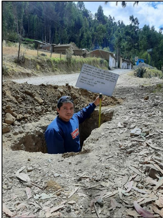
Fotografía 25: Medición de profundidad. Calicata N°010
