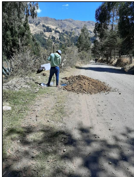
Fotografía 12: Excavación de calicata N°05
