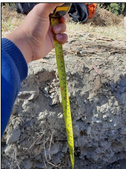
Fotografía 20: Profundidad 1.5 m. Calicata N°08
