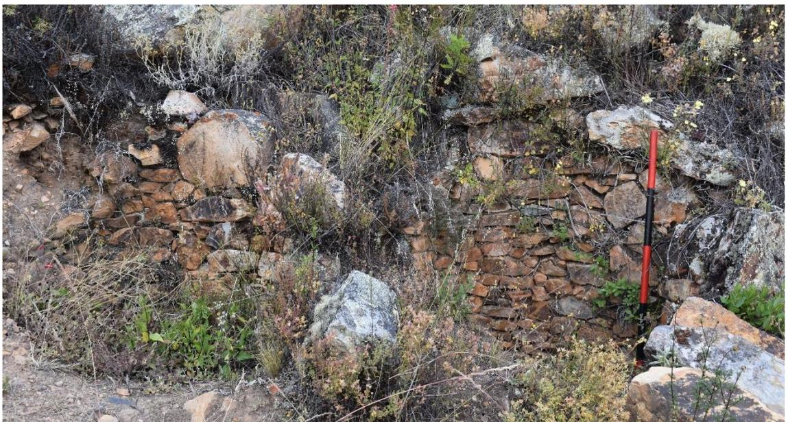
**Fig. 33** Foto general del perfil de las cistas circulares construidas con la técnica constructiva del pachillado uniforme.
