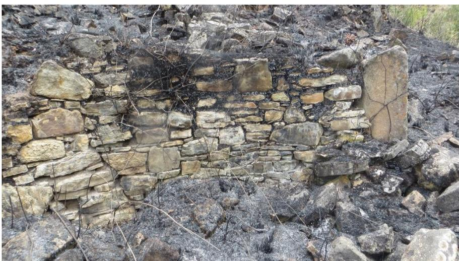
**Fig. 62** Foto general del perfil de un muro construido en base al pachillado uniforme con huancas en el acceso. *Fuente:* Castillo, C. 2019
