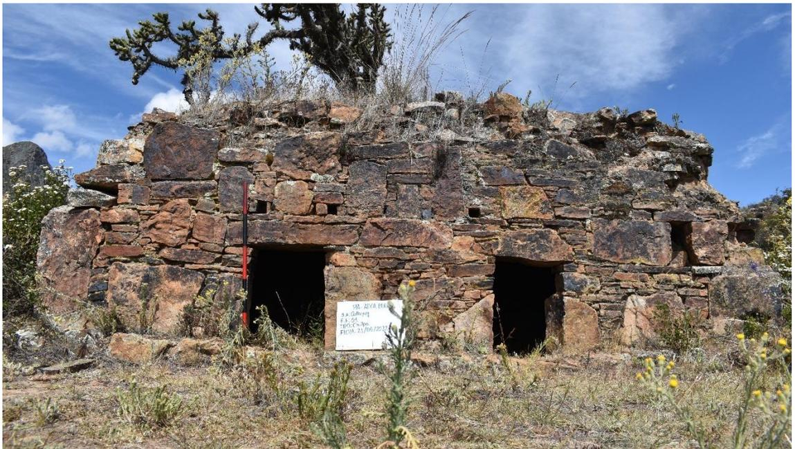
**Fig. 42** Foto general del exterior de la chullpa 01 construida por la técnica huanca – pachilla con dos divisiones. *Fuente:* Gomero, C. 2022
