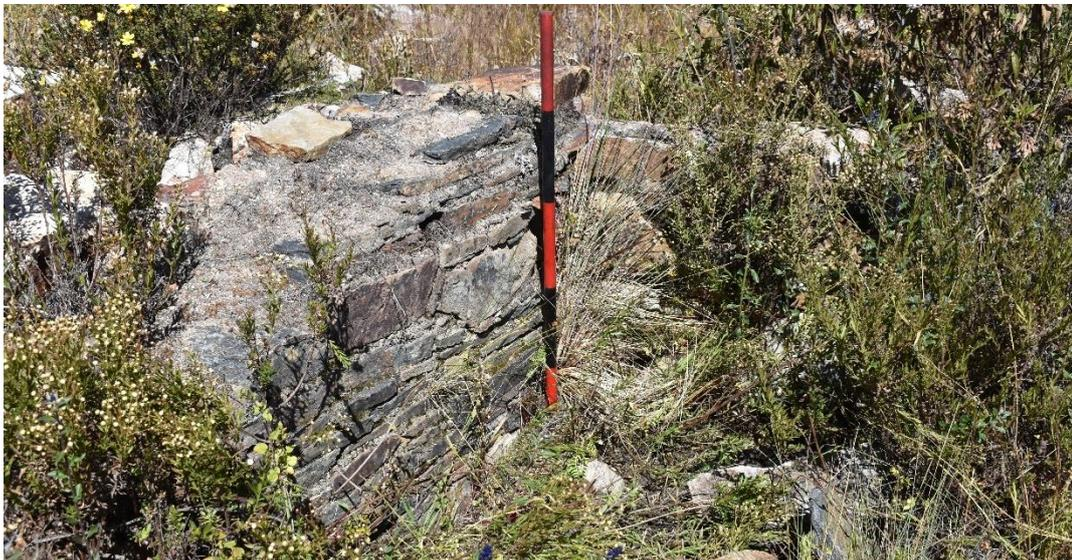
**Fig. 37** Foto general del perfil del muro de un recinto cuadrangular construido con la técnica del pachillado uniforme. *Fuente:* Gomero, C. 2022
