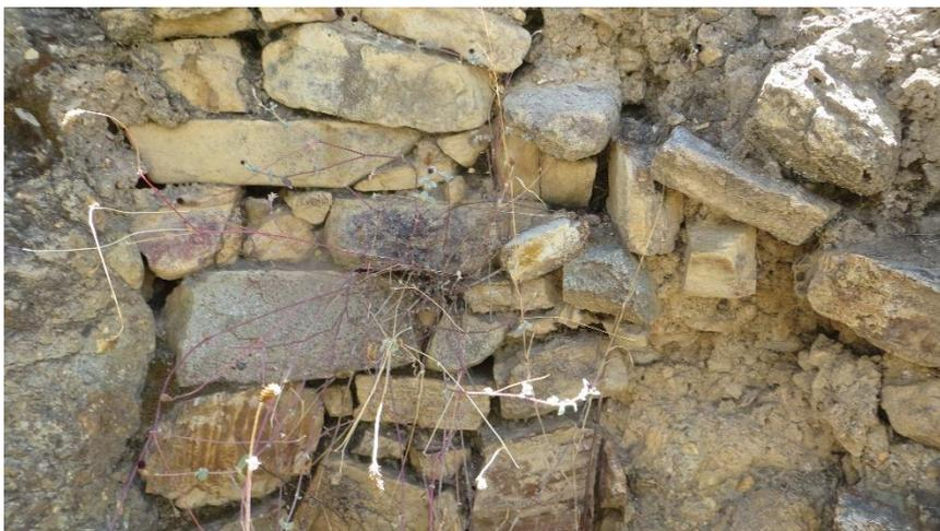
**Fig. 83** Foto detalle del perfil del muro de una de las cistas circulares, construido a base del pachillado uniforme. *Fuente:* Castillo, C. 2016
