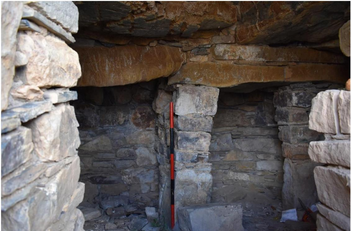
**Fig. 27** Foto general del interior de la Chullpa 01 del sector Chuchun Punta, donde se observa la técnica pachillado uniforme. *Fuente:* Gomero, C. 2022
