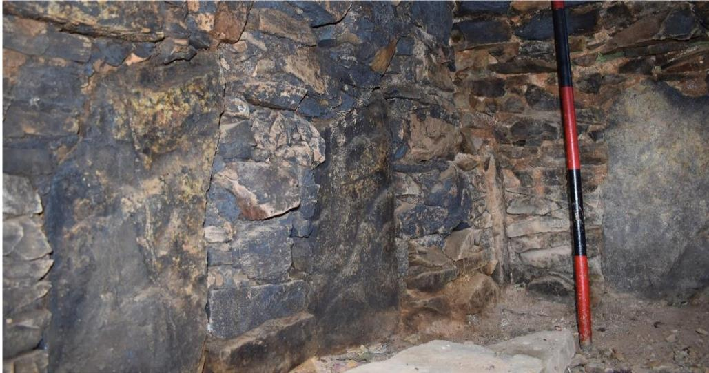
**Fig. 43** Foto detalle del interior de una de las divisiones de la chullpa 01, construida por la técnica huanca - pachilla. *Fuente:* Gomero, C. 2022
