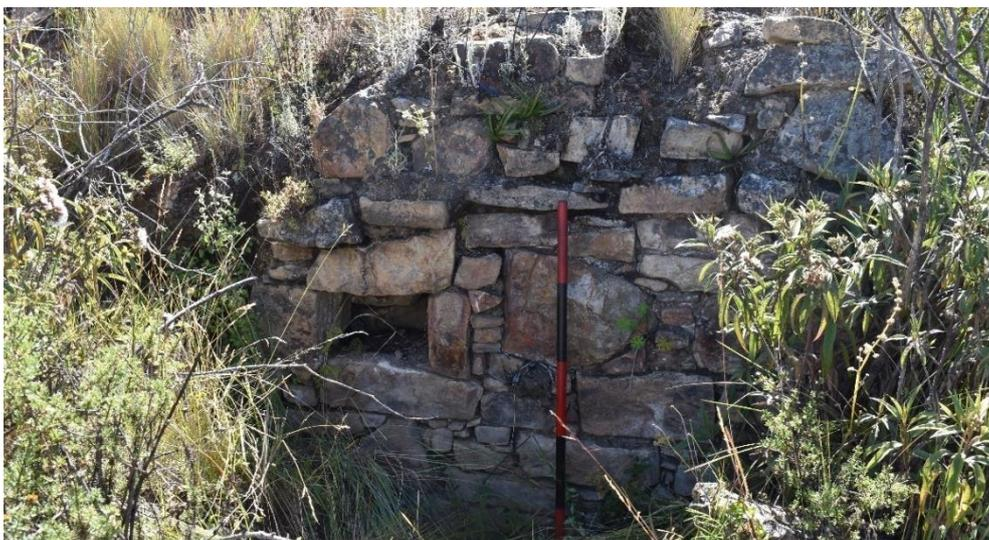
**Fig. 38** Foto general del perfil de un muro de un recinto cuadrangular construido con la técnica de huanca - pachilla. *Fuente:* Gomero, C. 2022
