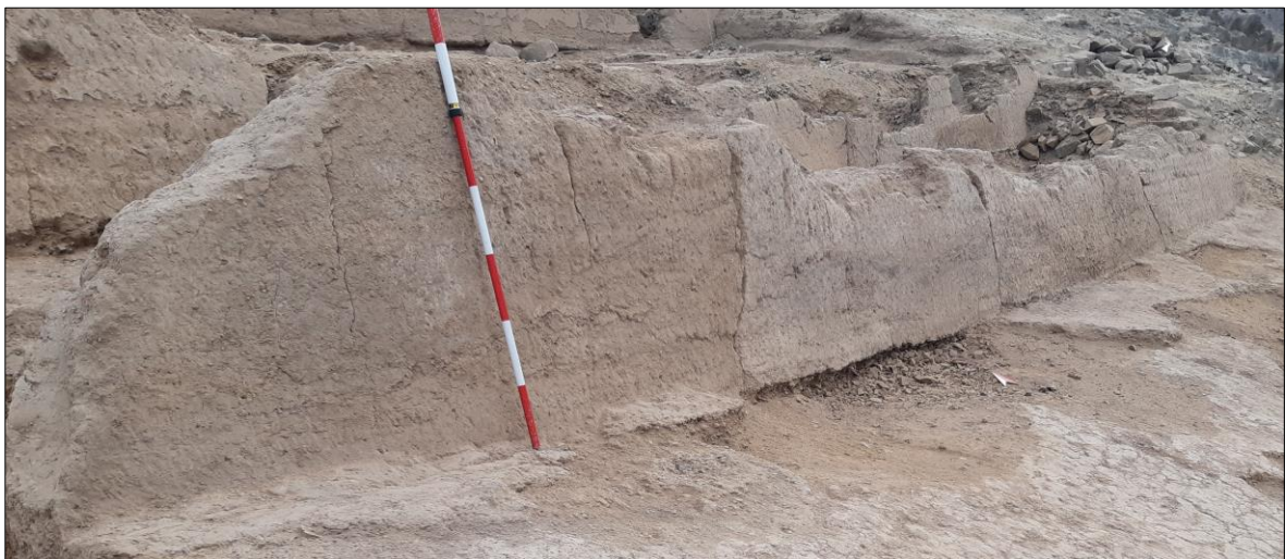
Figura 164. Foto del muro de tapia EA. 9 de tipo contención con paños irregulares. Segundo Momento Constructivo (II). Proyecto de Rescate Arqueológico Cerro Huaca.
