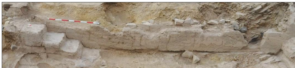
Figura 165. Foto de muro de tapia EA. 3A de tipo interno, adosado en paralelo con el EA. 3A y se le adosa la EA. 7 (Escalera 1). Segundo Momento Constructivo (II). Proyecto de Rescate Arqueológico Cerro Huaca.
