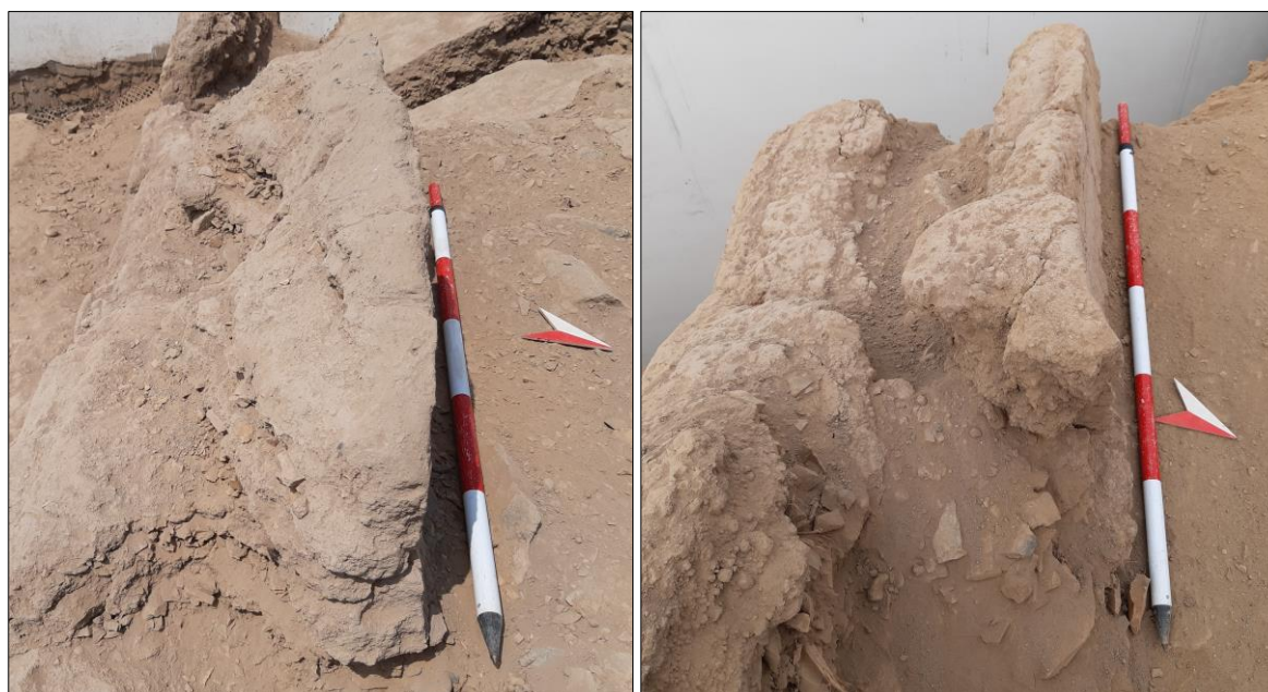
Figura 167. Foto del muro de tapial EA. 11 (izquierda) y foto del muro de tapial EA. 23 ambos de tipo interior y de crecimiento. Segundo Momento Constructivo (II). Proyecto de Rescate Arqueológico Cerro Huaca.
