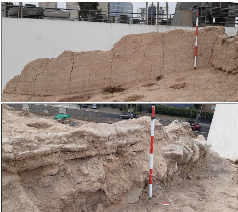
Figura 140. Foto del muro de tapial EA. 17, de tipo contención con los bloques de tierra modelados irregulares (superior) y su relleno piedras y barro como soporte estructural (inferior). Proyecto de Rescate Arqueológico Cerro Huaca.
