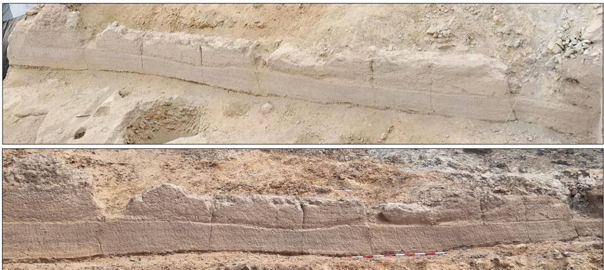
Figura 138. Fotos de muro de tapial EA. 1, de tipo contención con paños irregulares y estriados. Proyecto de Rescate Arqueológico Cerro Huaca.
