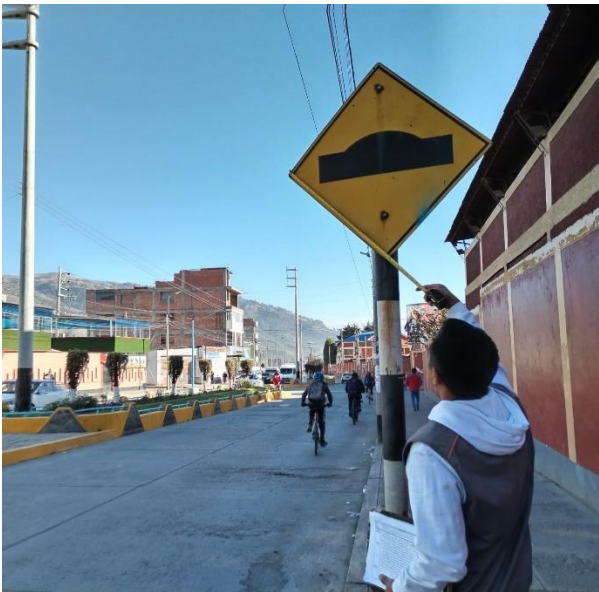
Señal preventiva “REDUCTOR DE VELOC. TIPO RESALTO” – Av. Centenario
