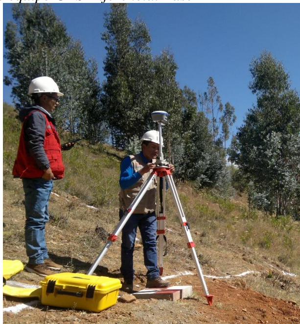
Colocación de equipo GPS Diferencial Base
