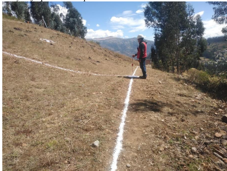
Figura 50 Nivelación y enfoque de mini prisma
