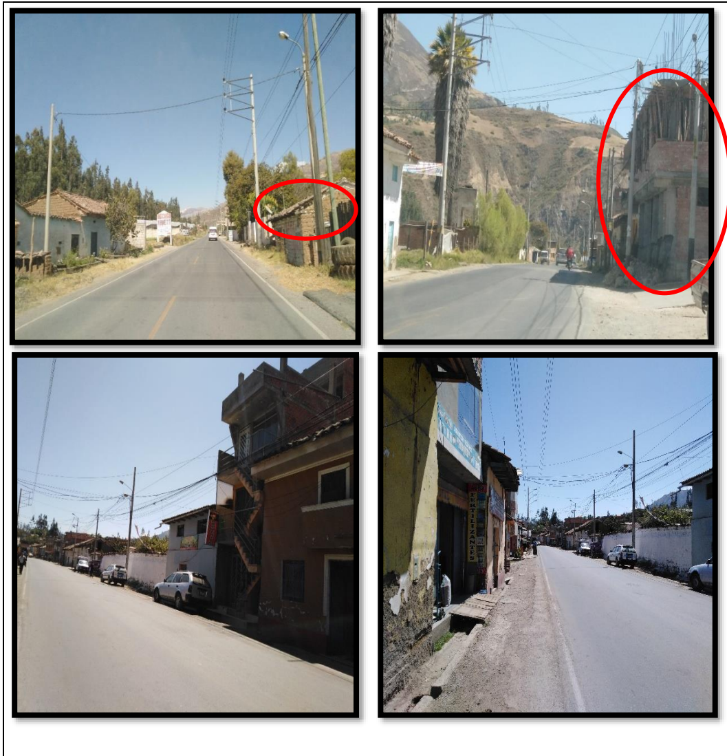
Casos de afectación de predios al derecho de vía, cerca de la calzada.
