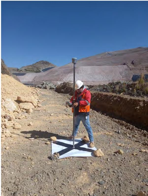
Levantamiento de puntos de fotocontrol con receptor rover GNSS TRIMBLE R10 en modo RKT y colector TRIMBLE TSC3, estos puntos de fotocontrol son para verificar la precisión y error del procesamiento fotogramétrico.
