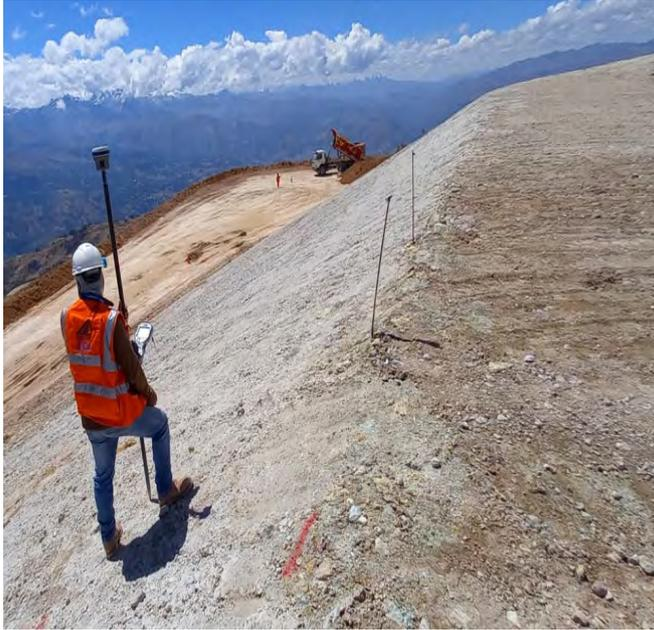
Levantamiento superficial con receptor rover GNSS TRIMBLE R10 en modo RKT y colector TRIMBLE TSC3, Levantamiento de zonas liberadas en talud inferior de la banquetta 01.
