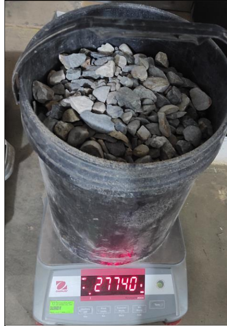
Foto 36: Pesado del agregado grueso según el diseño de mezcla
