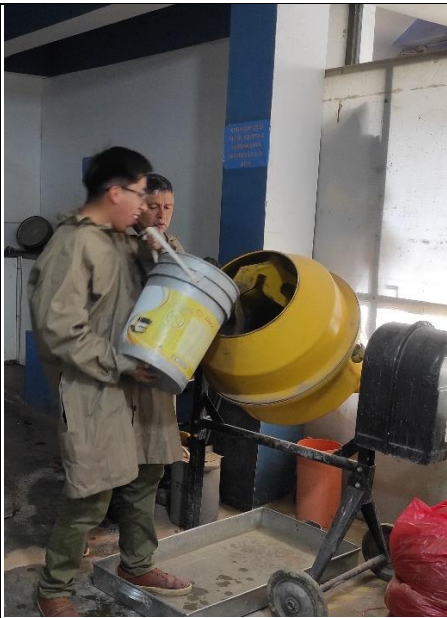
Foto 45: Mezclado de los materiales en la mezcladora
