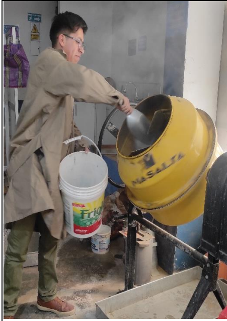
Foto 47: Mezclado de los materiales en la mezcladora
