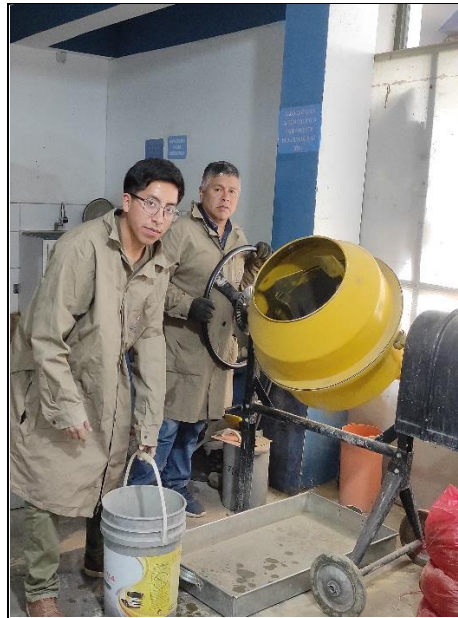
Foto 46: Mezclado de los materiales en la mezcladora
