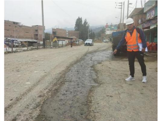
Foto 28: verificación de desgaste de la vía por erosión
