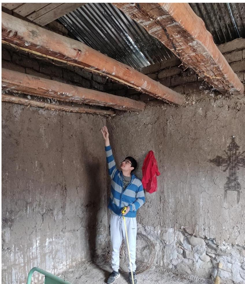
La vivienda cuenta con un sobrecimiento de concreto y piedra mediana, como se muestra en la Figura 34, que rodea todo su perímetro. No se observan asentamientos en ningún lado de la vivienda, y tampoco hay grietas en las paredes de adobe. A pesar del paso de
