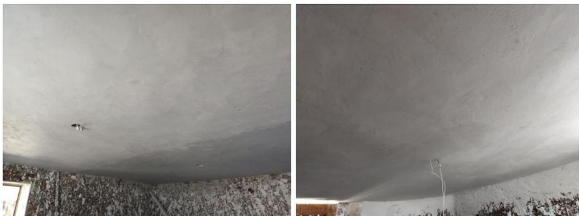
Para llevar a cabo la siguiente toma de datos, se esperó aproximadamente un mes después de finalizar los trabajos. El propósito de este tiempo de espera fue permitir que el yeso se secase correctamente. Después de este periodo, se ubicaron nuevamente los medidores de temperatura y humedad en los mismos sitios. Se realizaron mediciones durante 15 días con intervalos de una hora cada una, comenzando el día 16 de enero de 2023 a las 00:00 y finalizando el día 30 de enero a las 23:00.
