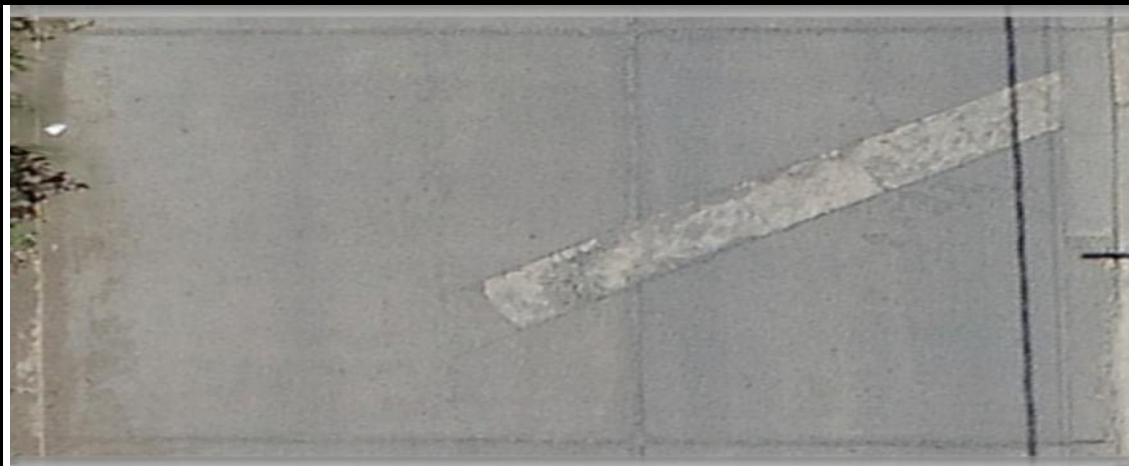
Daños:Parche grande de severidad alta y grieta de esquina de severidad media (29H y 22M)
