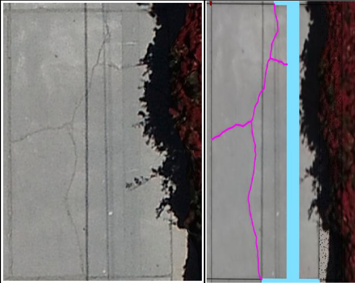
Daños: Parche grande de severidad baja y losa dividida de severidad media (29L y 23M)
