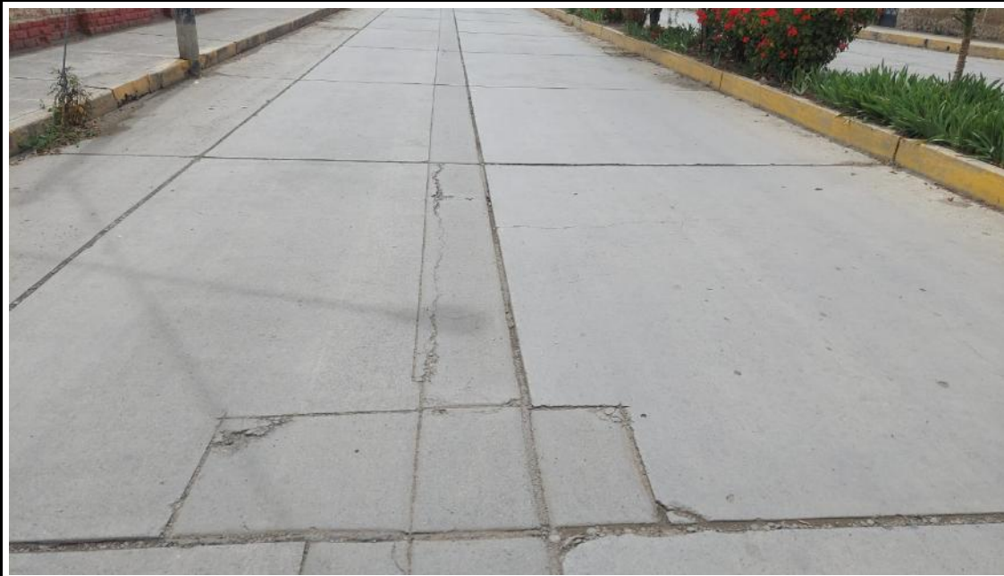
Daños: Parche grande de severida alta y parche pequeño de severidad media (29H y 30M)
