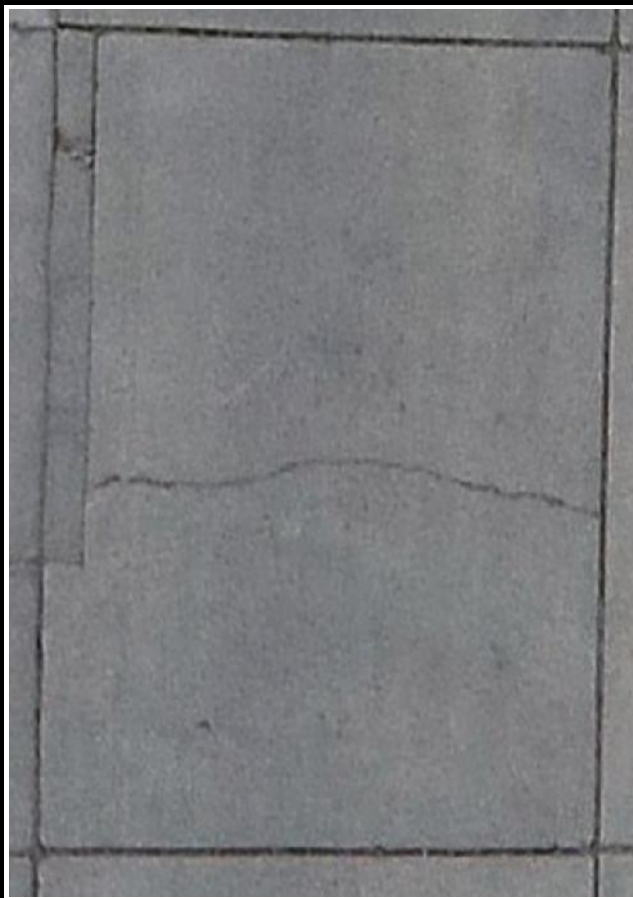
Daños: Parche grande de severidad alta y grieta lineal de severidad media (29H y 28M)
