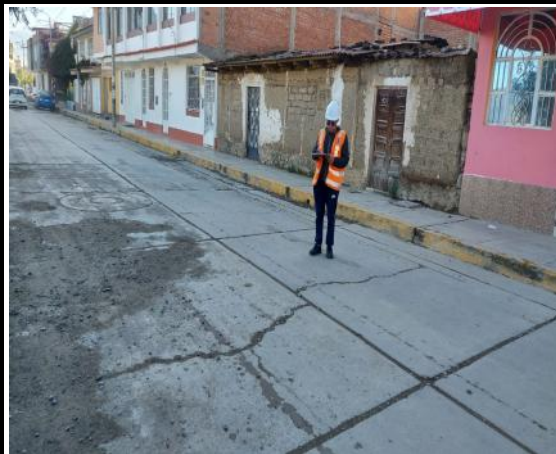
Medicion y registro de los daños de la Av. Atusparia, muestra UMD-01
