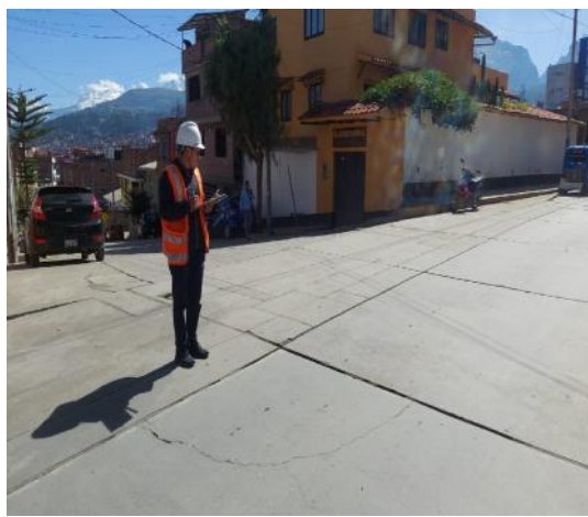
Medicion y registro de los daños de la Av. Atusparia, final de la via
