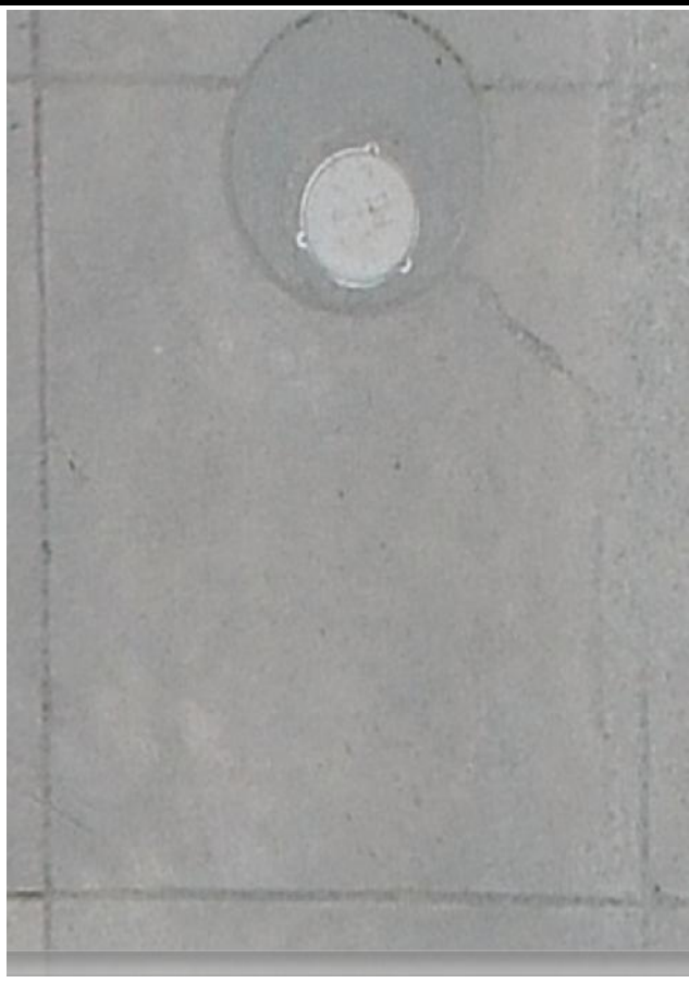
Daños: Grieta lineal de severidad alta (28H)
