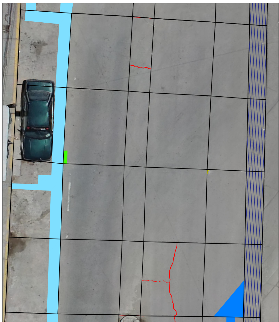
IDENTIFICACION DE DAÑOS
