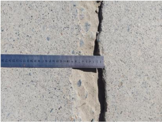
Medicion y registro de los daños de la Av. Atusparia, final de la via
