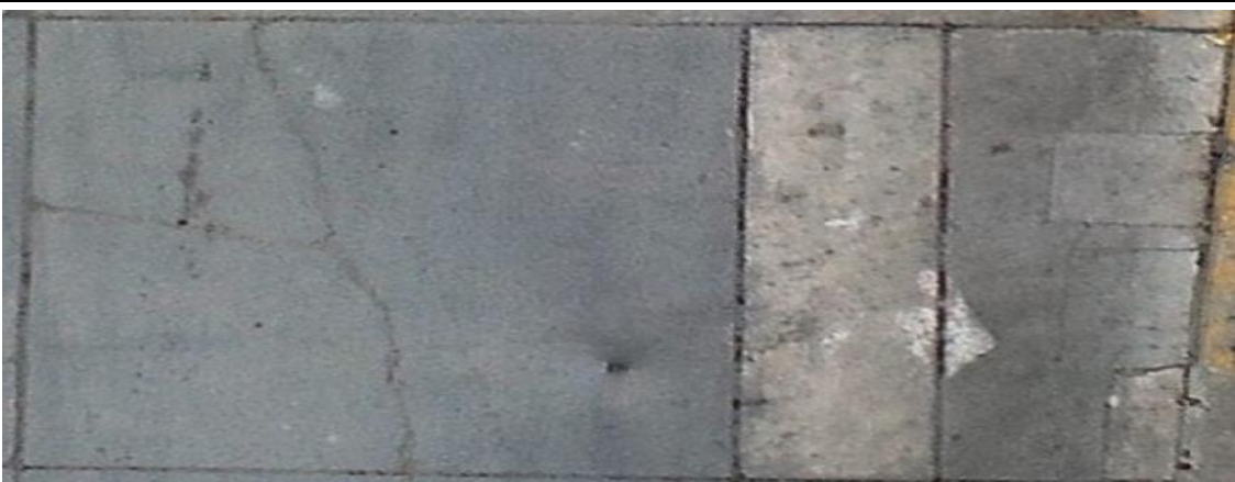
Daños: Losa dividida y parche de severidad media (23M y 29M)
