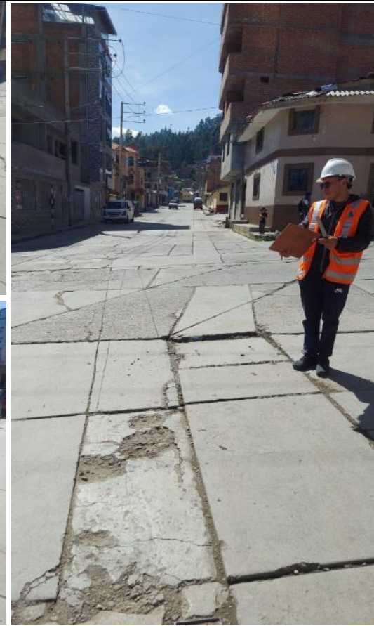
Medicion y registro de los daños de la Av. Atusparia, final de la via
