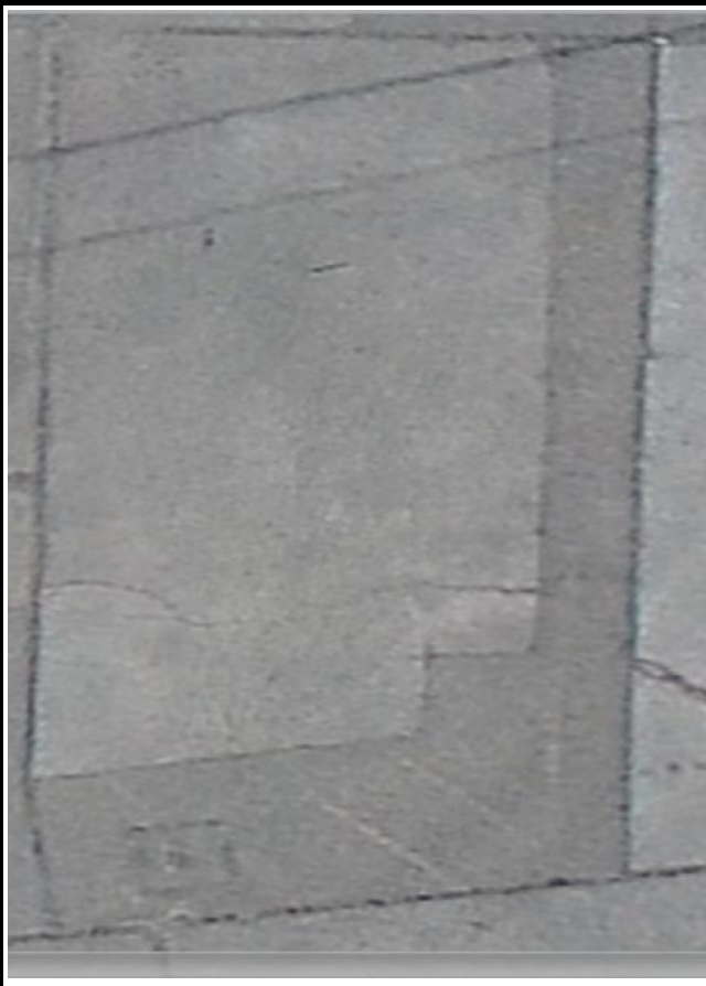
Daños: Grieta lineal, de esquina, parche grande de severida media (28M,29M, 22M)
