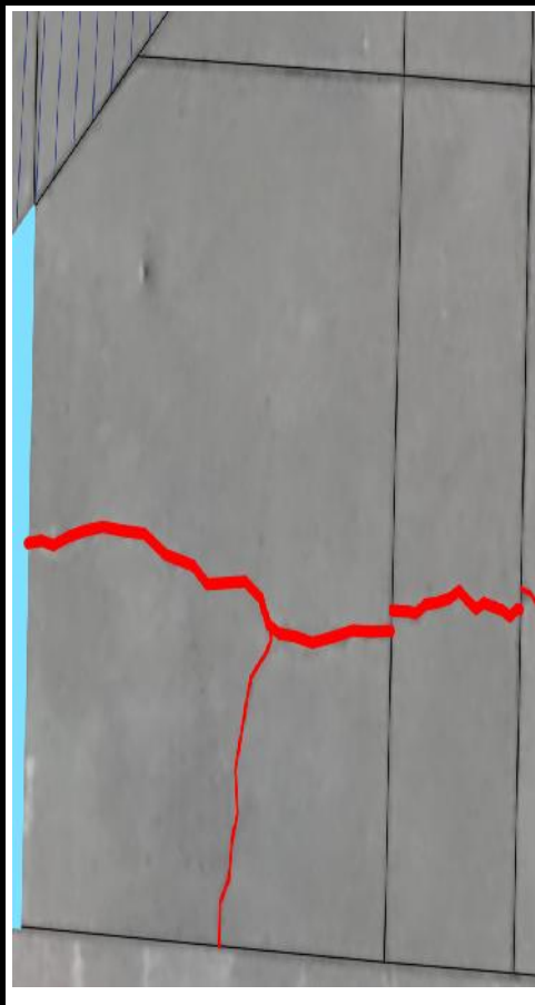
Daños: Grieta lineal de severidad media y alta (28M y 28H)
