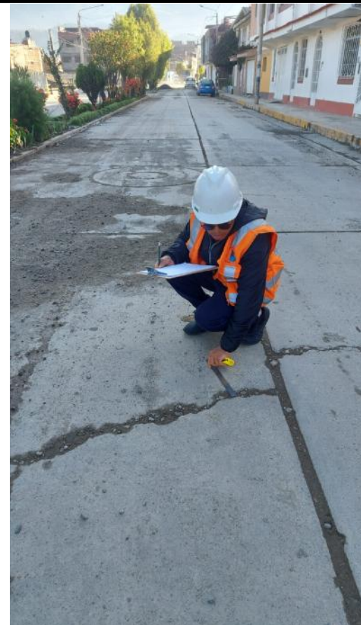
Medicion y registro de los daños de la Av. Atusparia, muestra UMD-01
