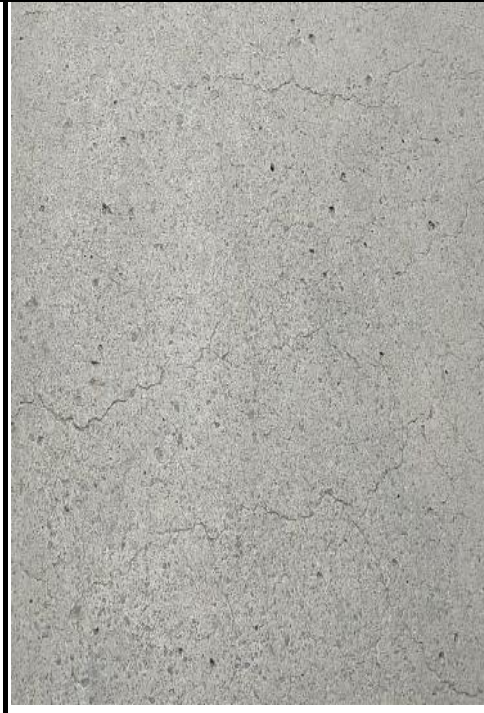
Daños: Grieta lineal, de esquina, parche grande de severida media (28M,29M, 22M). Craquelado bajo (36L)
