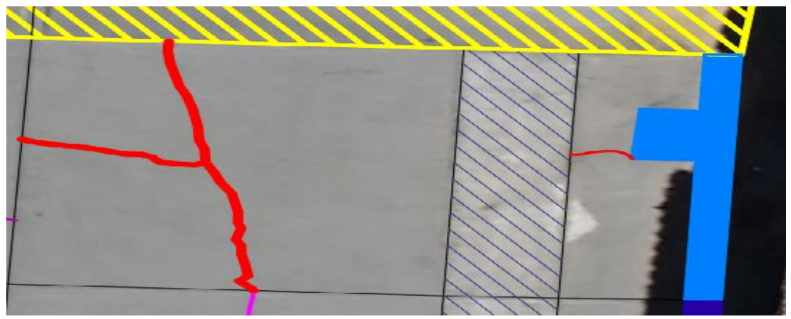
Daños: Grieta lineal de severidad alta y baja, parche grande de severidad media (28M, 28H y 29M)
