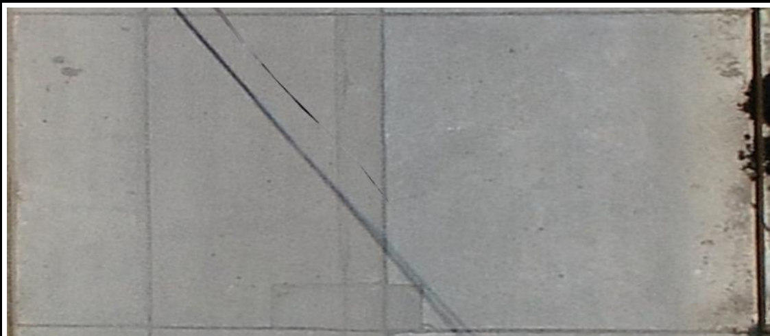
Daños: Parche grande de severida alta y parche pequeño de severidad media (29H y 30M)
