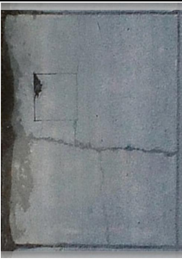
Daños: Parche grande de severidad alta y losa dividida de severidad media (29H y 23M)
