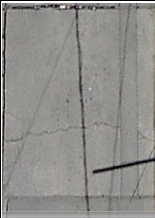
Daños: Parche grande de severidad baja y losa dividida de severidad media (29L y 34H)
