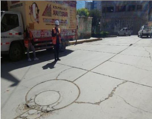
Medicion y registro de los daños de la Av. Atusparia, final de la via
