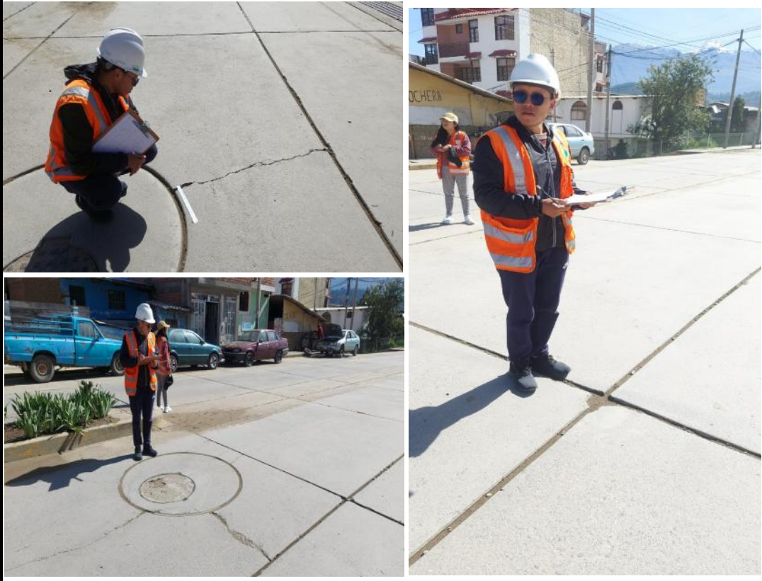
Medicion y registro de los daños de la Av. Atusparia, daños cerca a buzón
