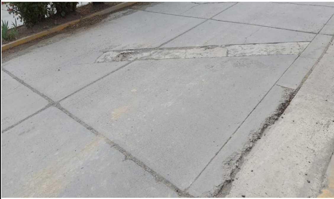
Daños:Parche grande de severidad alta y grieta de esquina de severidad media (29H y 22M)
