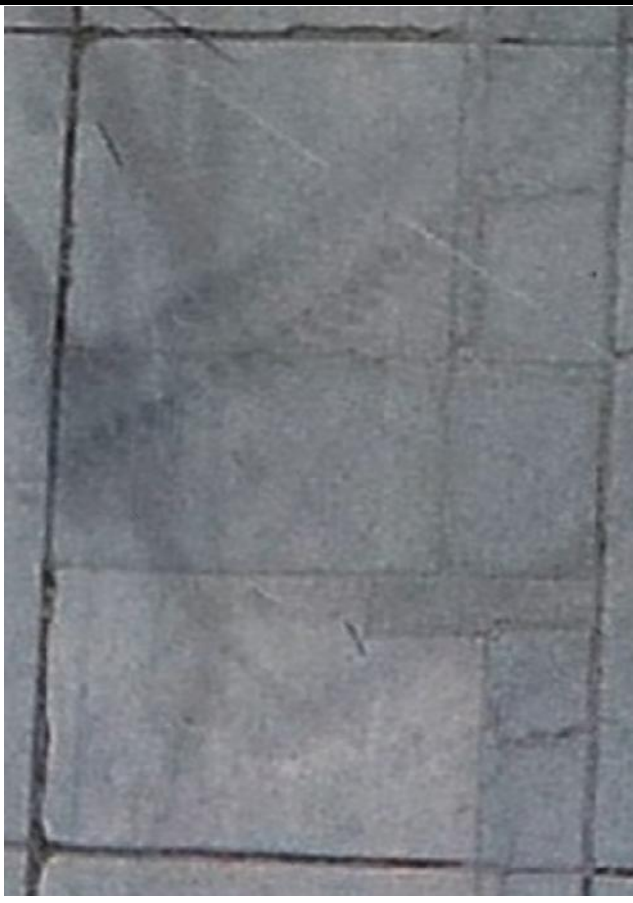
Daños: Parche grande de severidad baja y losa dividida de severidad media (29L y 23M)
