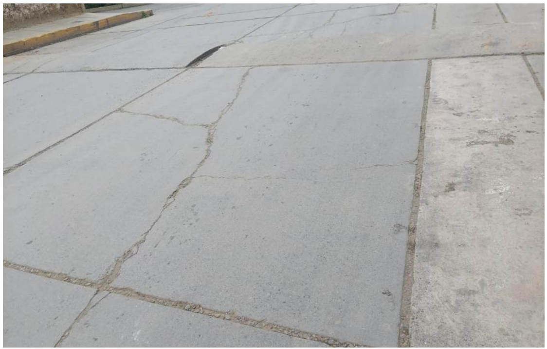
Daños: Losa dividida y parche de severidad media (23M y 29M)
