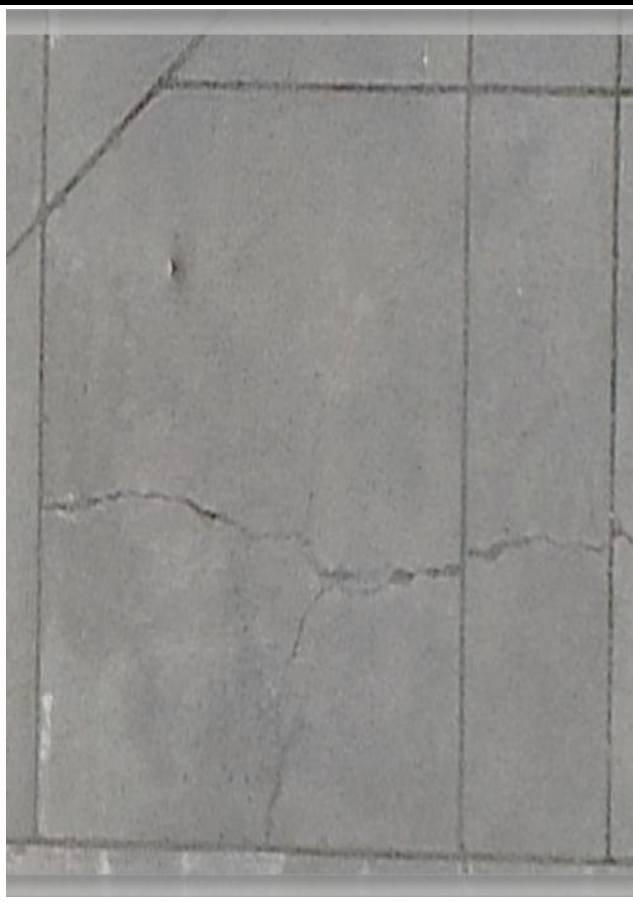
Daños: Grieta lineal de severidad media y alta (28M y 28H)
