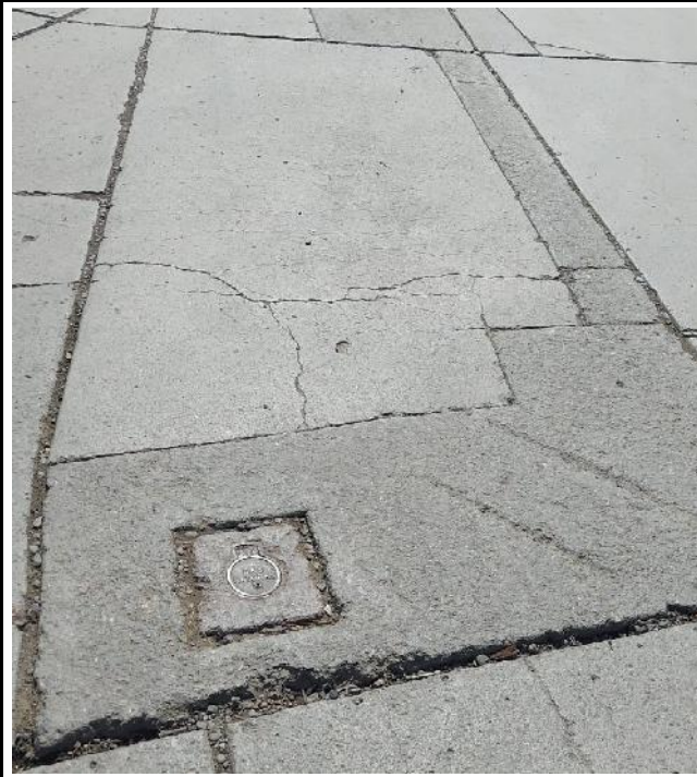
Daños: Grieta lineal, de esquina, parche grande de severida media (28M,29M, 22M). Craquelado bajo (36L)
