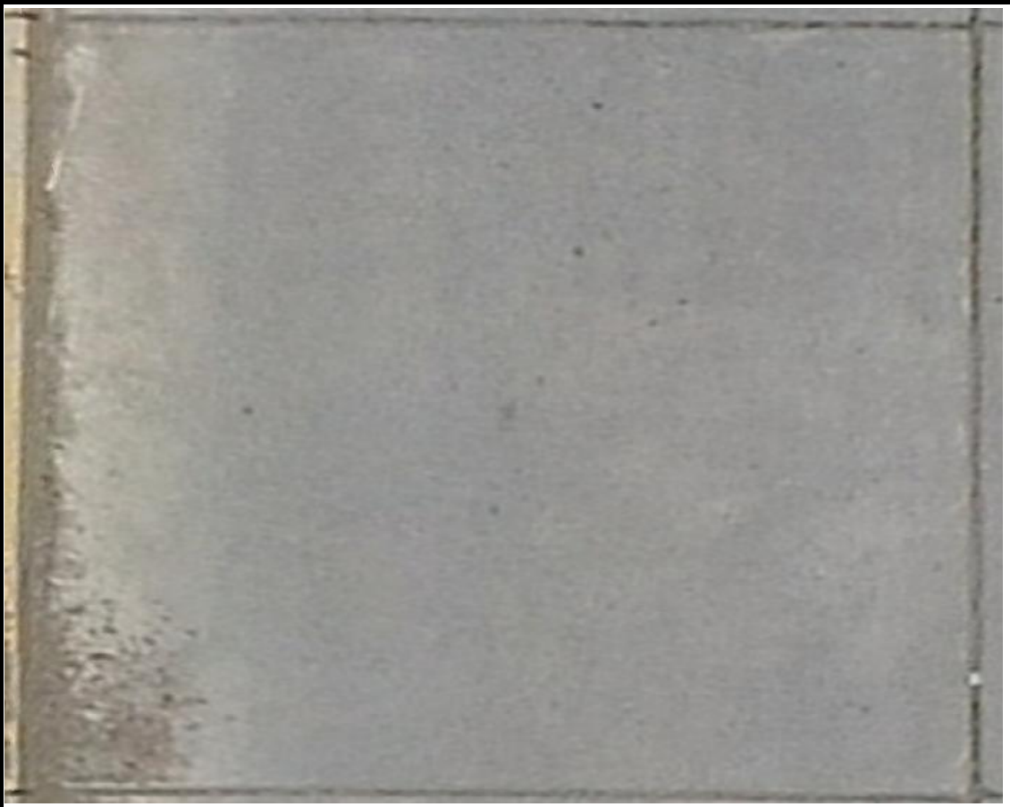
Daños: No detectado
