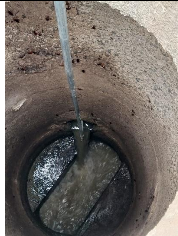
Fotografía N°04. Se identifica el interior del buzón que será aforado, el cual deberá cumplir con las características de medición de caudal.
