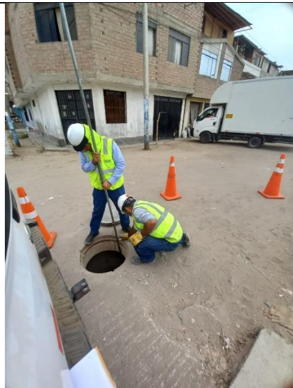
Fotografía N°08. Se deja el caudalímetro instalado al interior del buzón por un periodo de 7 días.
