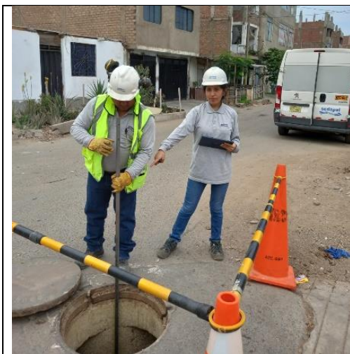
Fotografía N°09. Se repite el mismo procedimiento para los demás puntos a aforar.
