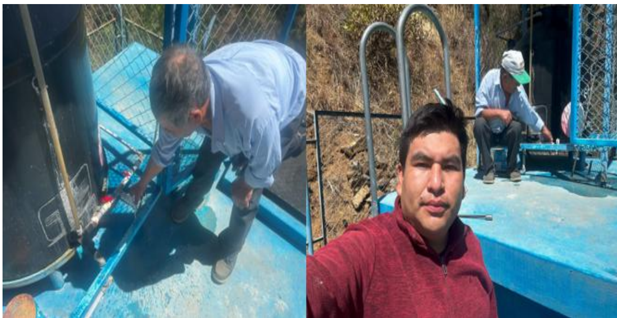
Foto N° 5 Calibración del caudal de goteo
