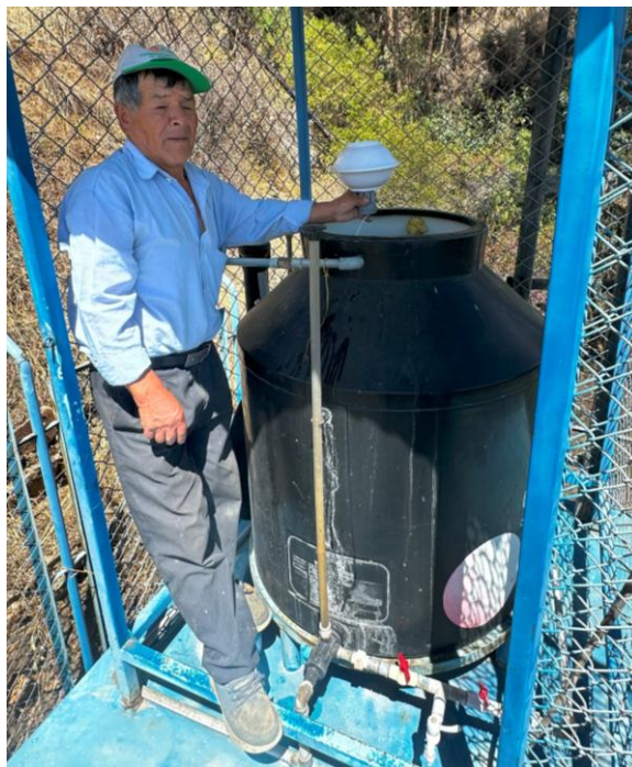
Foto N° 8 Flotador impulsor mejorado en funcionamiento
