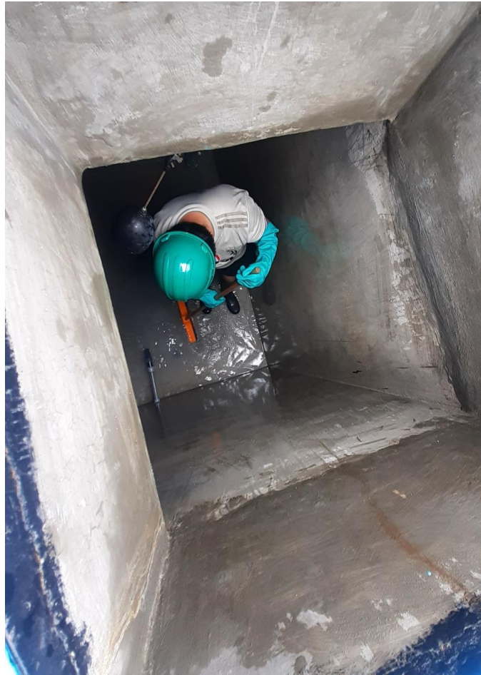
Foto N° 2 Limpieza y desinfección del sistema de agua potable del ccpp Bellavista
