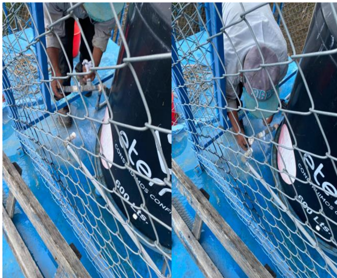
Foto N° 1 Mantenimiento del sistema de cloración
