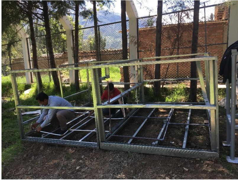
Foto N° 05: Abocardando para la instalación de accesorios en la Tubería Reticulado PEX.
