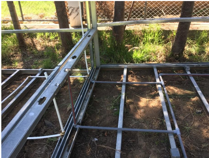
Foto N° 06: Vista de la Instalación de tubería PVC ½" C-10.
