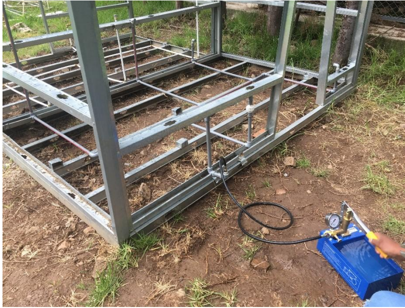
Foto N° 25: Vista de la prueba hidráulica en la tubería PVC C-10 de ½"
