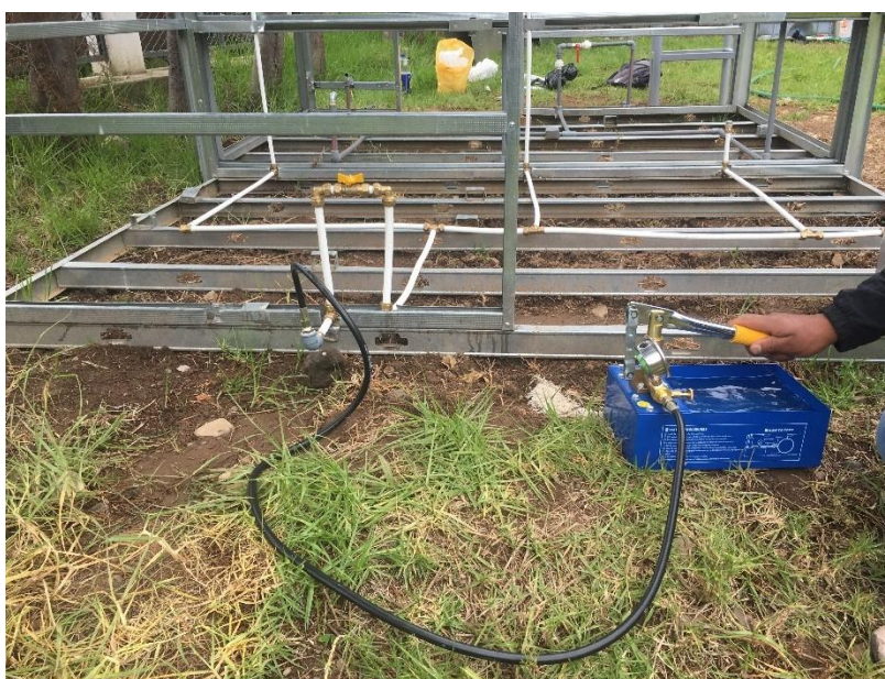
Foto N° 21: Realizando la prueba hidráulica en la Tubería Reticulado PEX.
