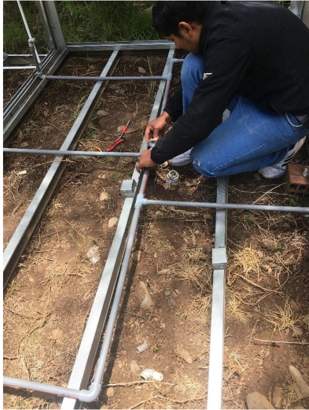
Foto N° 17: Vista de la reparación de la tubería PVC C-10 de ½”
