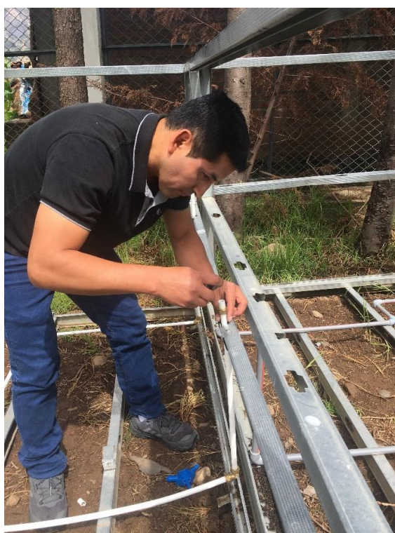
Foto N° 10: Vista de la colocación del tapón en la Tubería Reticulado PEX de ½”
