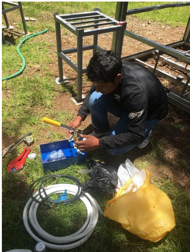
Foto N° 18: Vista del Armado del Balde de Prueba Hidráulica de alta presión.
