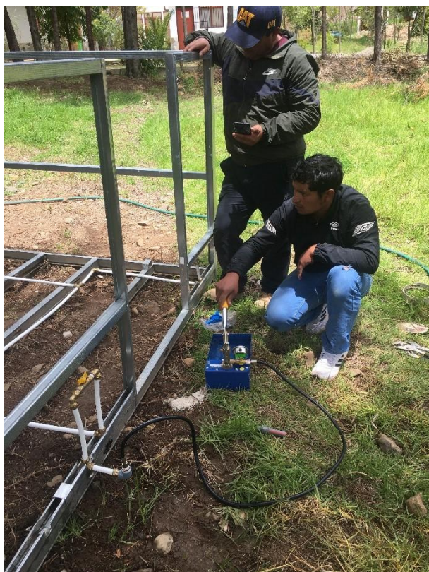
Foto N° 22 Realizando la prueba hidráulica en la Tubería Reticulado PEX.
