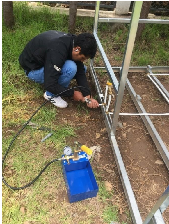
Foto N° 19: Conexión al ingreso de la llave de control para realizar la prueba. Hidráulica
