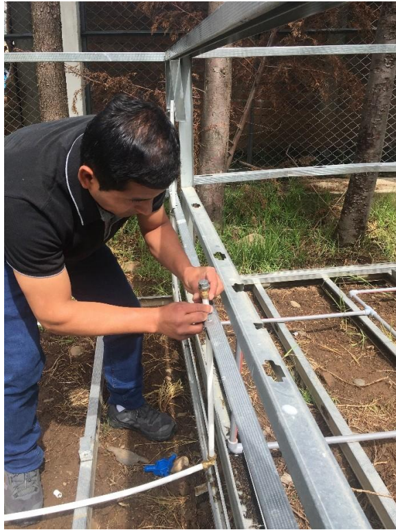
Foto N° 11: Vista de la colocación del tapón en la tubería Reticulado PEX de ½"
