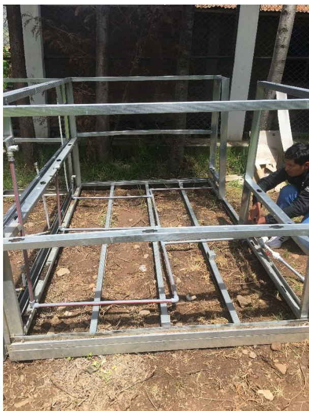
Foto N°14: Vista de la instalación de la tubería PVC C-10 de ½”
