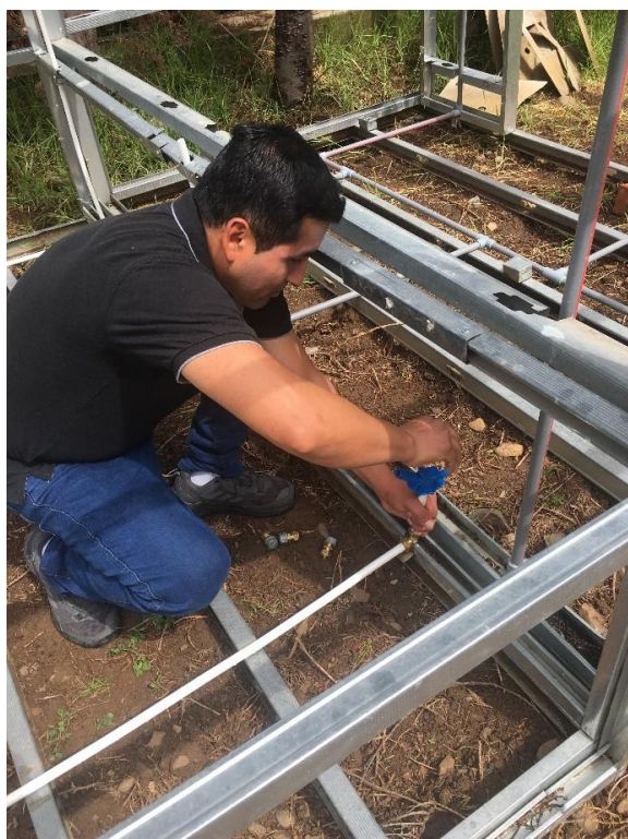
Foto N° 09: Vista del abocardado para la colocación del tapón en la tubería Reticulado PEX.
