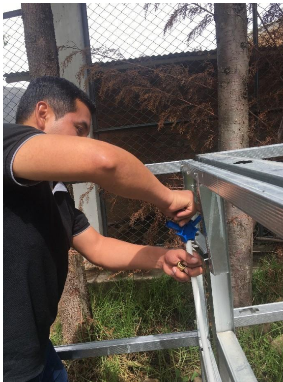
Foto N° 12: Vista del abocardado para la colocación del tapón en la tubería Reticulado PEX ½"
