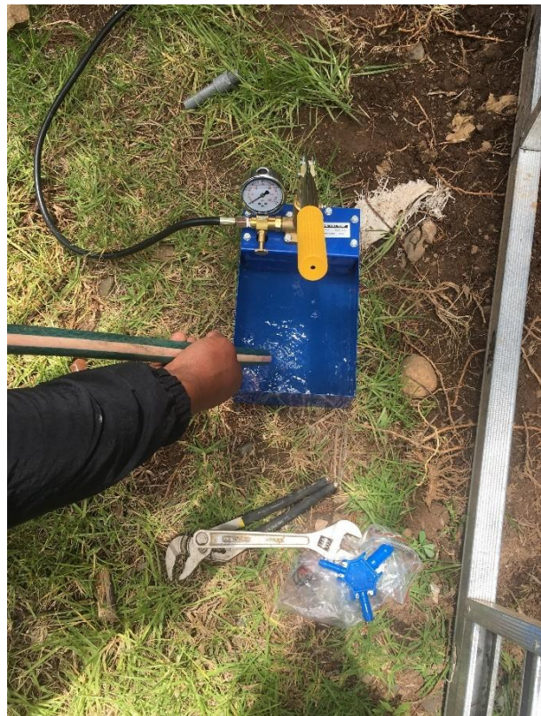
Foto N° 20: Vista del llenado de agua para realizar la Prueba hidráulica
