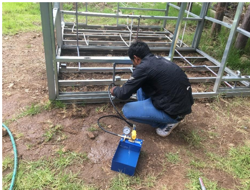
Foto N° 24: Vista de la instalacion para realizar la prueba hidraulica en la tuberia PVC C-10 DE ½"
