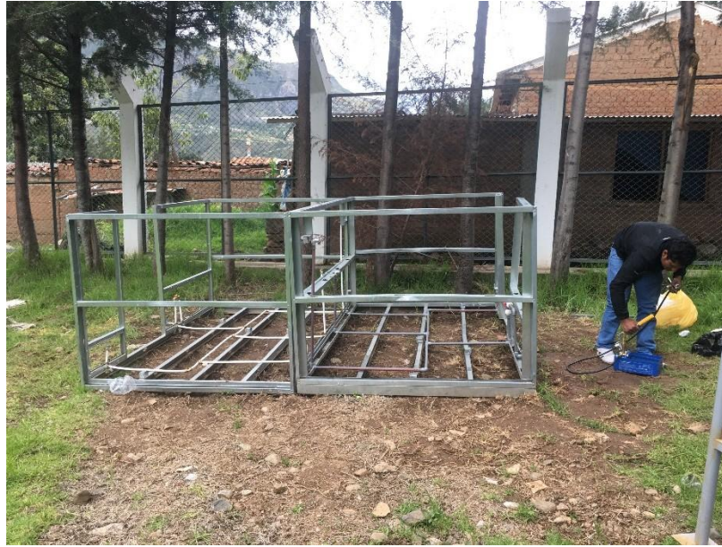
Foto N° 27: Vista del armado e instalación de la tubería reticulado PEX y tubería PVC C-10 de 1/2"
