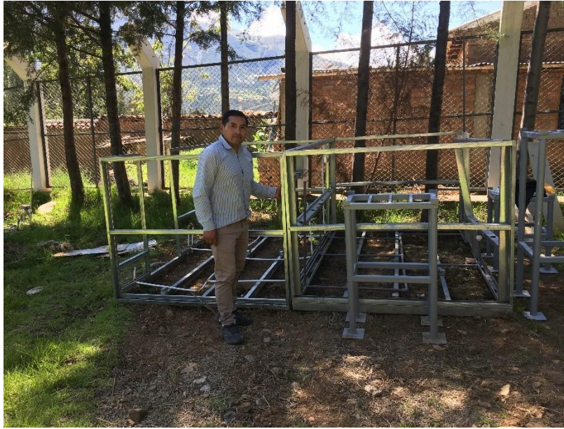
Foto N° 07: Vista de la Instalación de la tubería Reticulado Pex y Tubería PVC ½” C-10.
