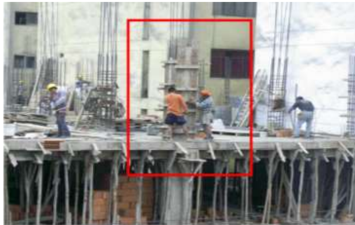
Figura 10. No existe la implantación adecuada con Arnés y líneas de vida, primera vista. Elaboración propia.
