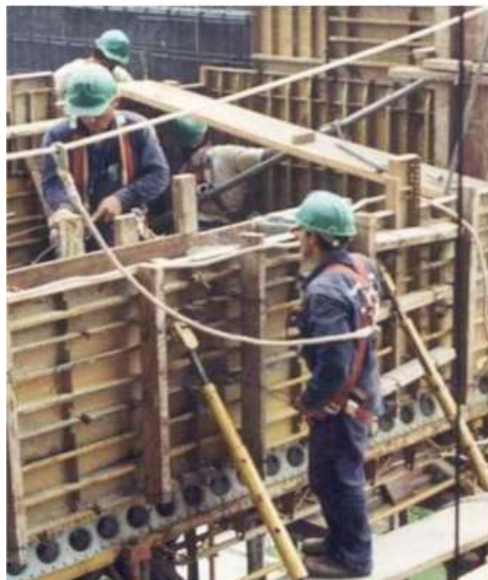
Figura 12. Se implementó al personal con Arnés, con la línea de vida respectiva.
