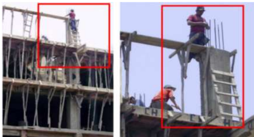
Figura 10. No existe la implantación adecuada con Arnés y líneas de vida, primera vista. Elaboración propia.
