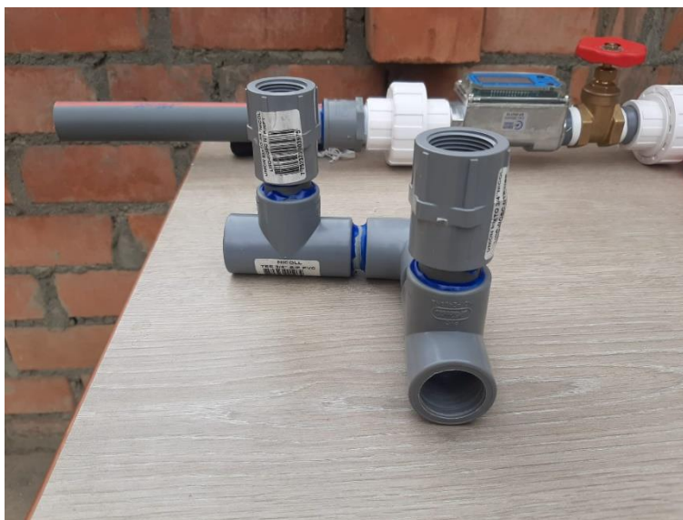
Figura 18 Codo 90° PVC SP diámetro 3/4" - Punto B
