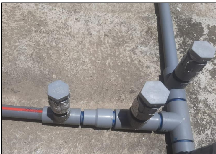
Figura 22 Reducción PVC SP diámetro 3/4" a 1/2" - Punto D
