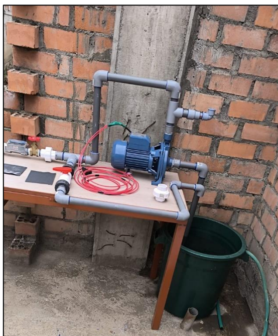
Figura 23 Instalación de bomba de agua
