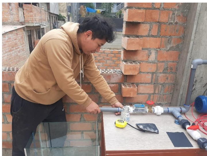
Figura 27 Construcción del circuito hidráulico
