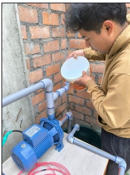
Figura 5 Arranque de la bomba, y puesta en marcha para las pruebas.
