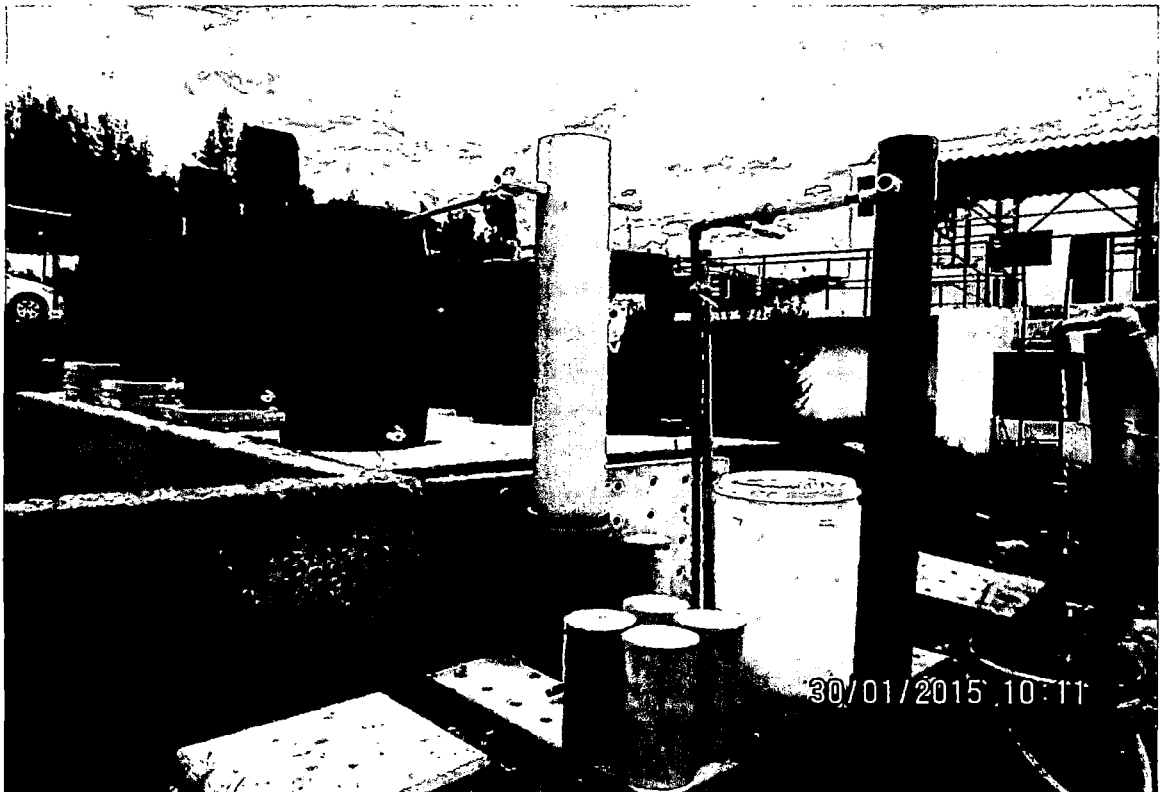
Foto 18: Planta piloto de Bellavista en pleno funcionamiento.
