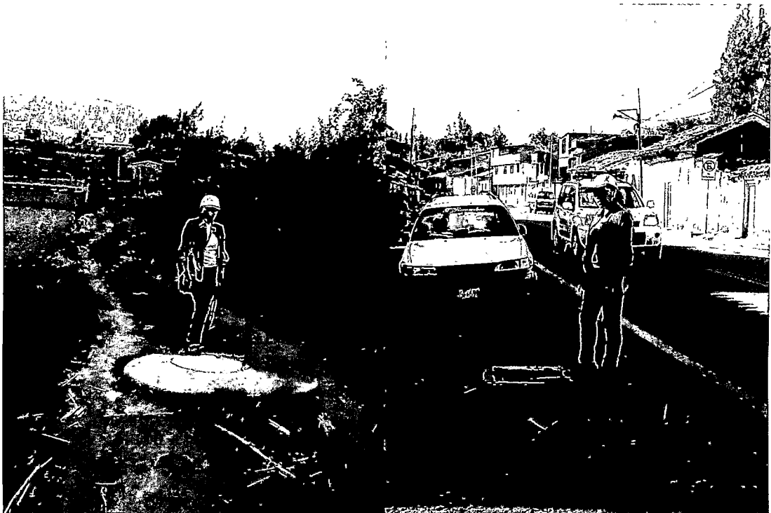
FOTOGRAFIA N° 06: los colectores y conexiones domiciliarias en mal estado a la periferia de la ciudad de Marcará.
