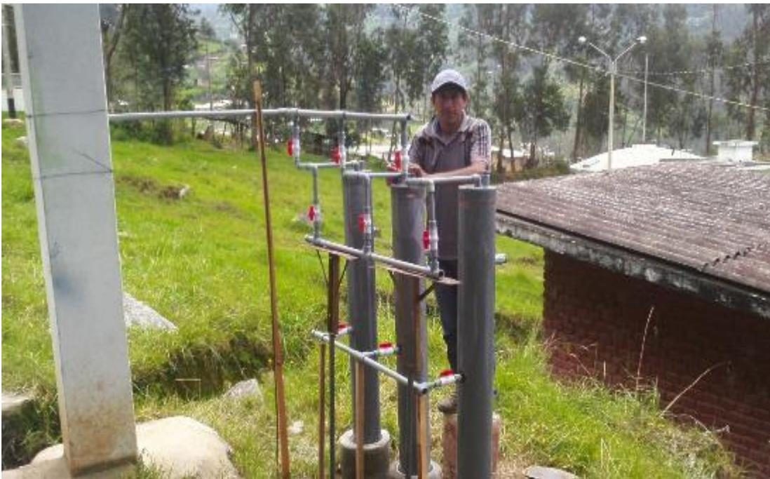
Fotografía N° 4 Construcción del filtro a presión piloto
