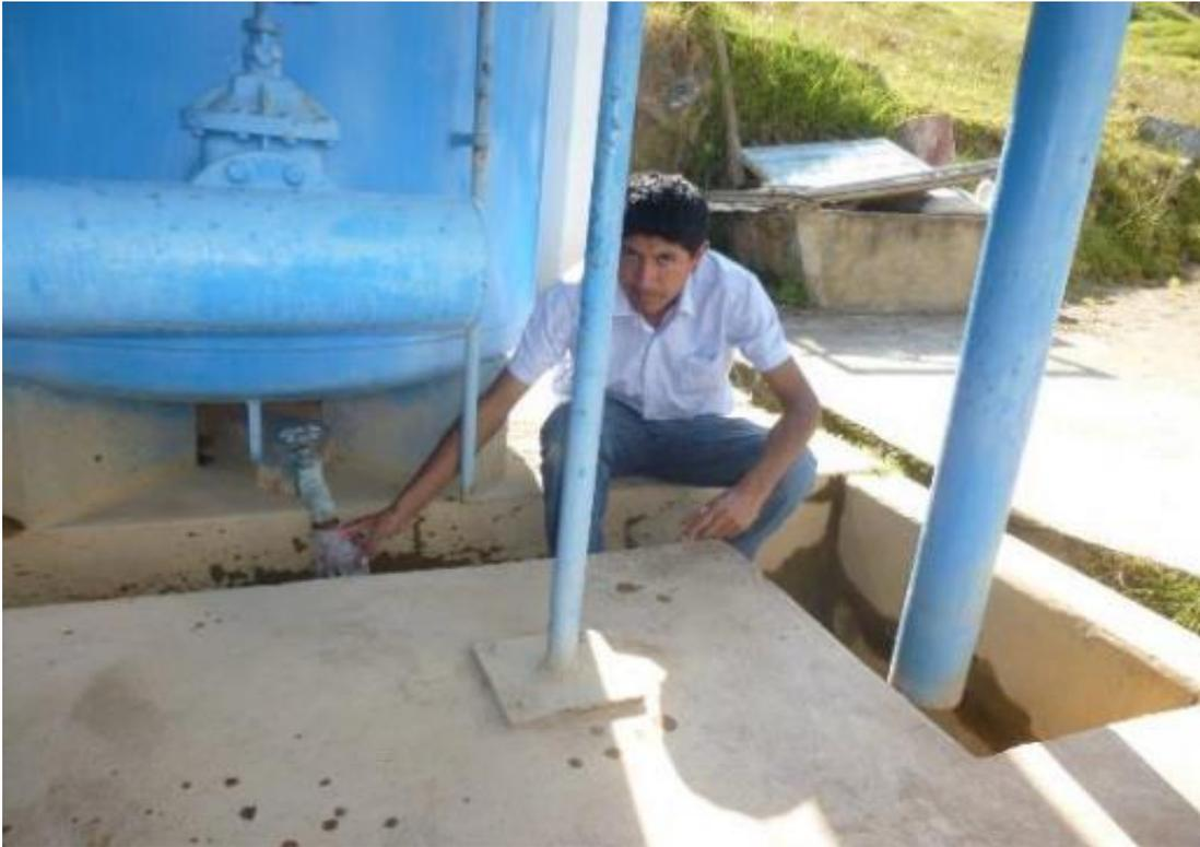
Fotografía N° 3 Toma de muestra de agua a la salida del filtro existente.
