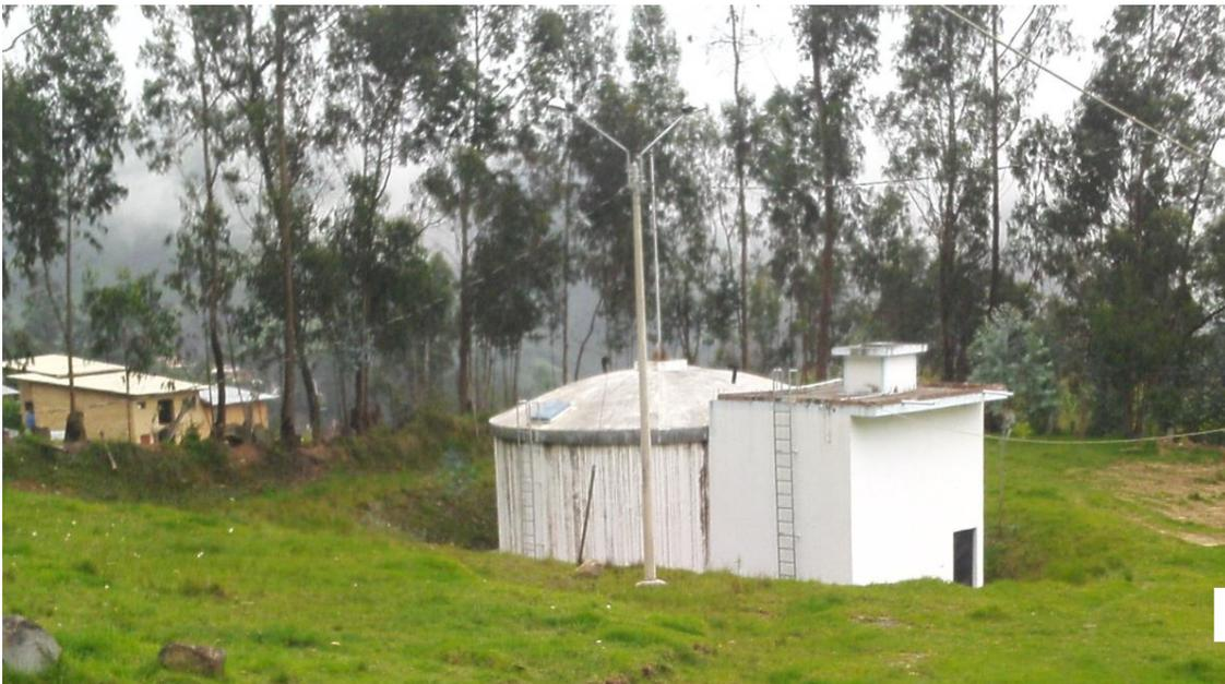
Fotografía N° 7 Reservorio circular de agua potable
