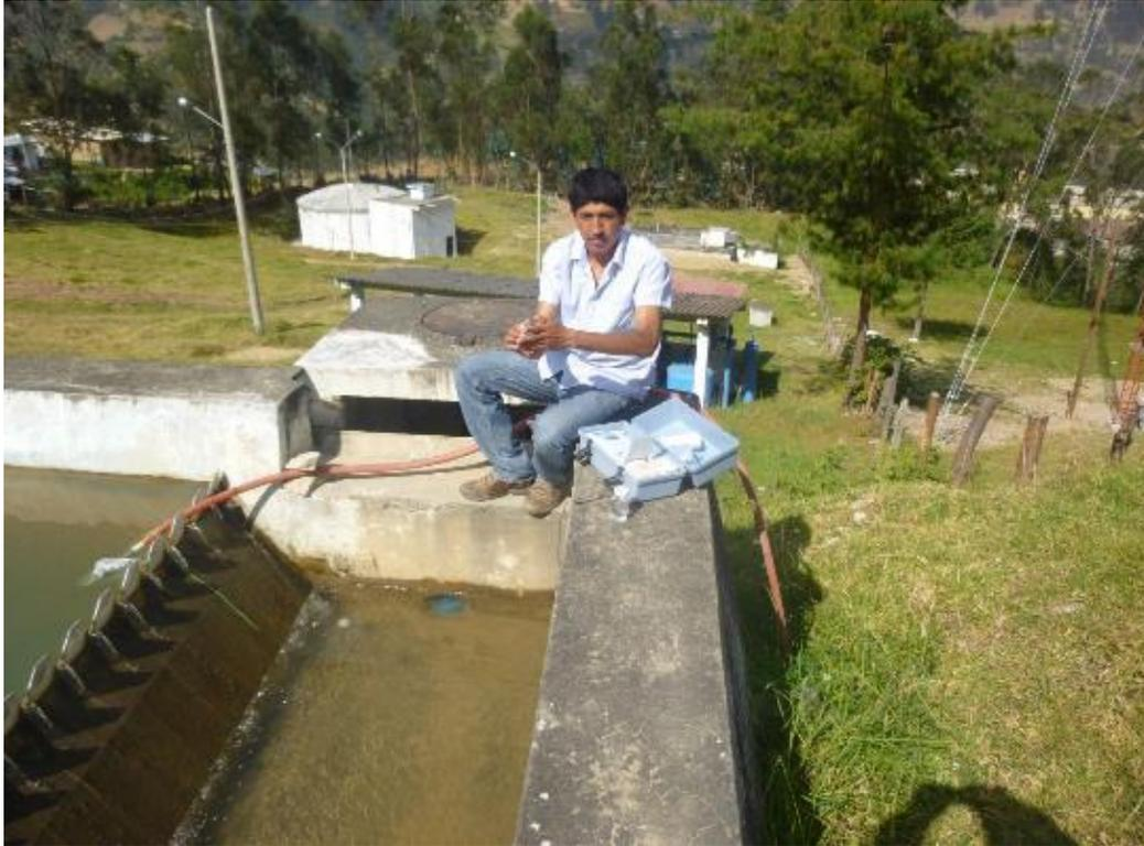
Fotografía N° 10 Toma de agua decantada mediante manguera
