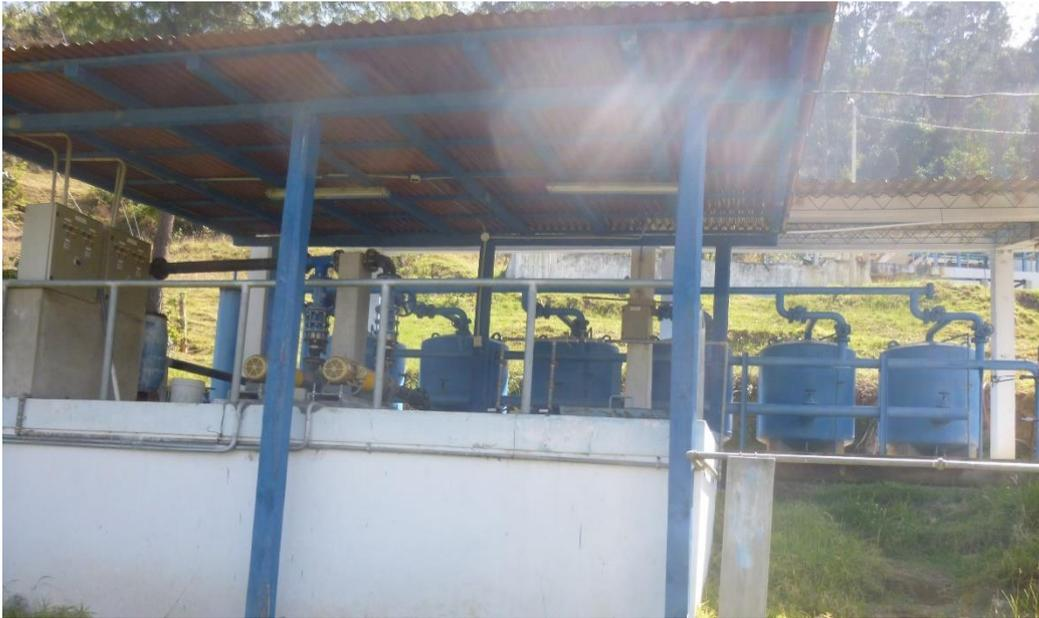
Fotografía N° 6 Bateria de Filtros a presión
