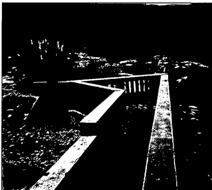
Imagen N°4 Canal de Captación del Agua.
