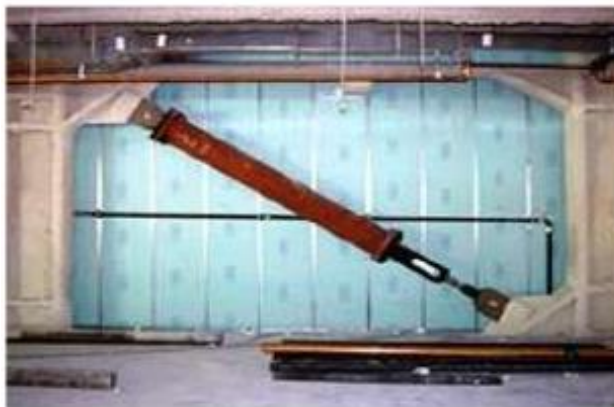
Figura 11. Disipador de Energía de Fluido Viscoso Fuente. Taylor Devices Inc.
