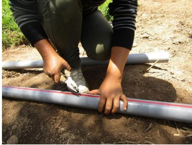
**Fotografía 38.** Realizando los orificios a la tubería de alimentación del HFSSV.
