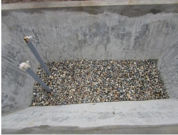
**Fotografía 29.** Colocación de la grava media dentro del HFSSV.
