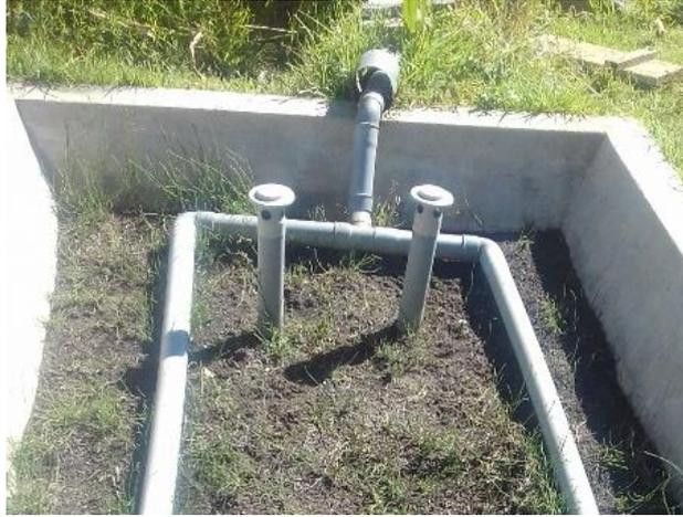
**Fotografía 44.** Sistema de ventilación del HFSSV.
