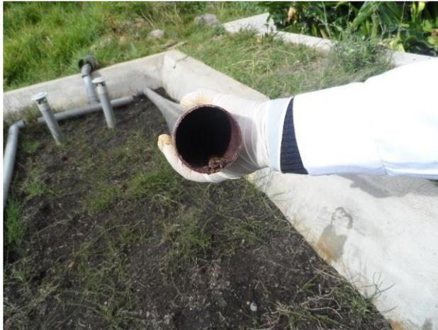
**Fotografía 51.** Se observa las tuberías de alimentación sucio.
