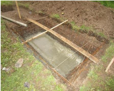
**Fotografía 6.** Excavación y vaciado de piso del humedal.
