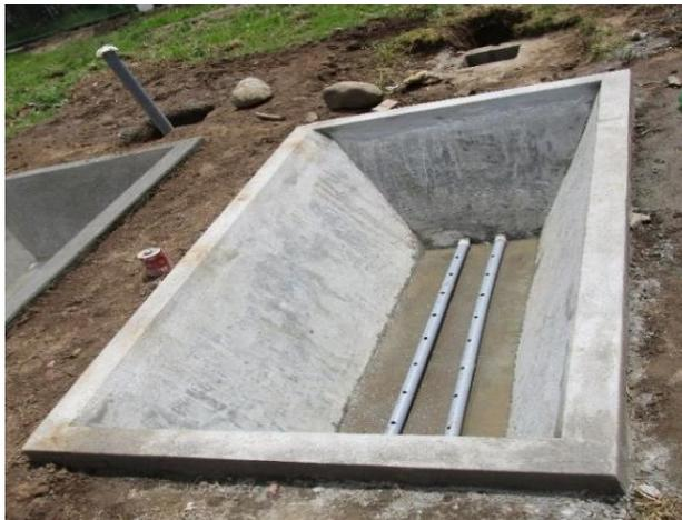
**Fotografía 28.** Colocación de la tubería de drenaje dentro del HFSSV.
