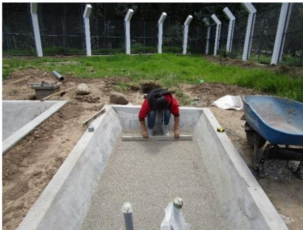
**Fotografía 31.** Colocación de la arena gruesa dentro del HFSSV.
