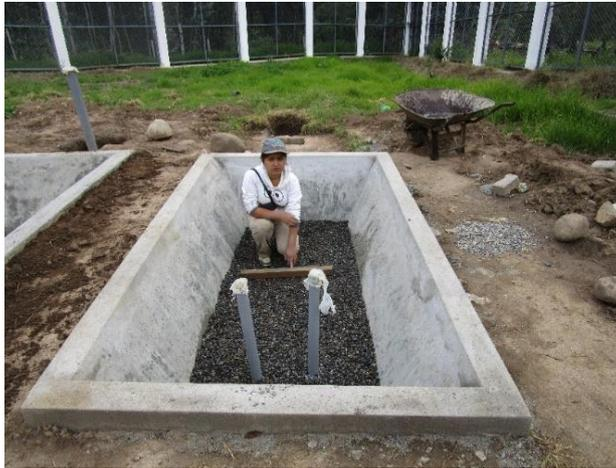
**Fotografía 30.** Colocación de la arena gravosa dentro del HFSSV.
