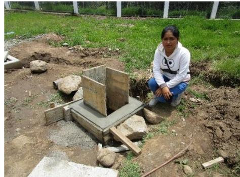
**Fotografía 9.** Encofrado y vaciado de concreto de la caja de recolección del humedal.
