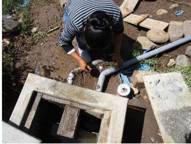
**Fotografía 41.** Conexión de tuberías desde el segundo vertedero hasta el HFSSV.
