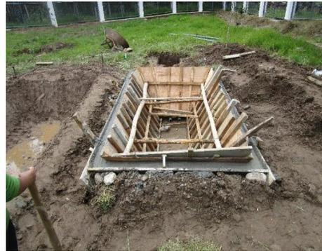
**Fotografía 7.** Encofrado del humedal.
