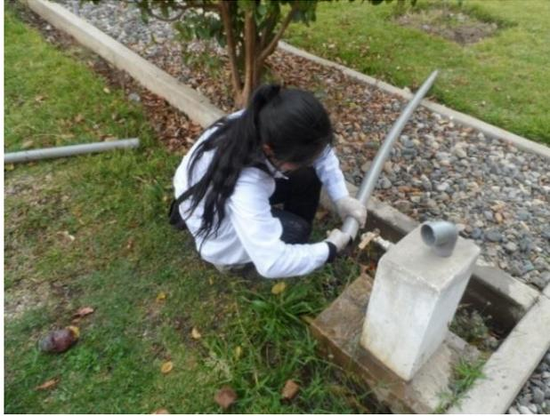
**Fotografía 53.** Se observa el lavado con agua por dentro de las tuberías.
