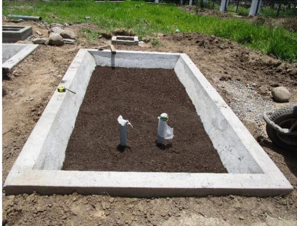
**Fotografía 32.** Colocación de la turba mezclado con arena dentro del HFSSV.
