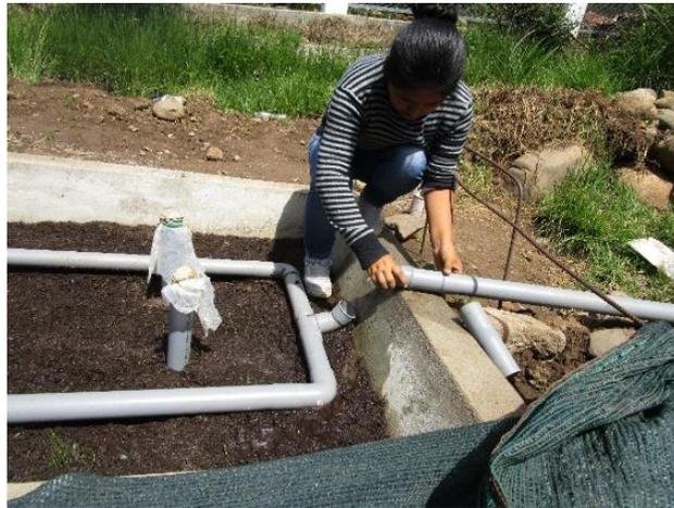
**Fotografía 42.** Conexión de las tuberías de alimentación dentro del HFSSV.
