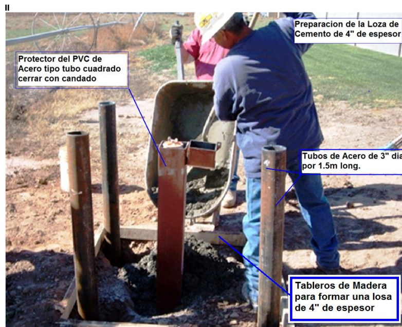
Figura N° 24: Instalación del sello superficial con la construcción de la Losa de Cemento y la Instalación de los Tubos de Protección
