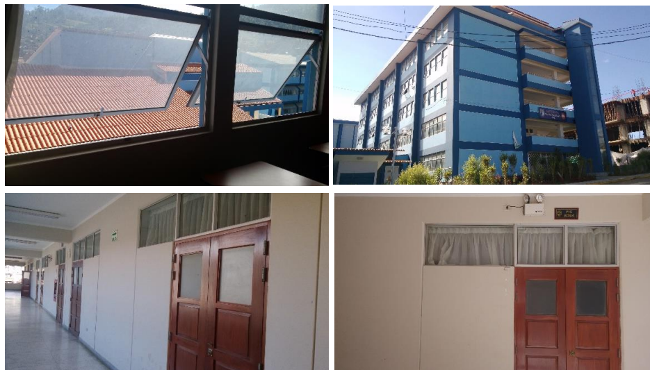
Fig. 25: Ventanas de iluminación y de ventilación de las aulas
