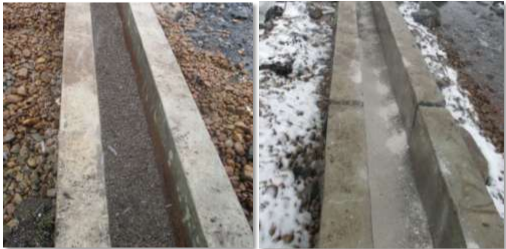
Imagen Nº 5: Colocado de material calcáreo
