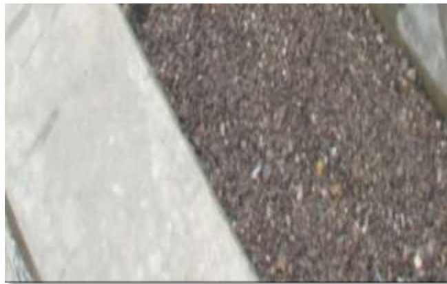
Imagen N° 8: Adición de la última capa (arena gruesa)
