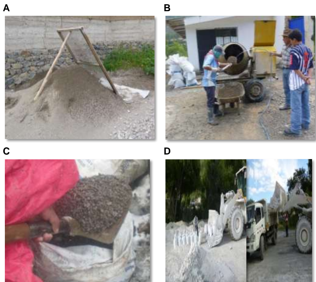
Imagen N° 2: Preparación de roca caliza. A: Tamizado del material. B: Lavado de grava y arena. C: Tamaño de la grava preparada. D: Carguío de material para su traslado a Pastoruri.
