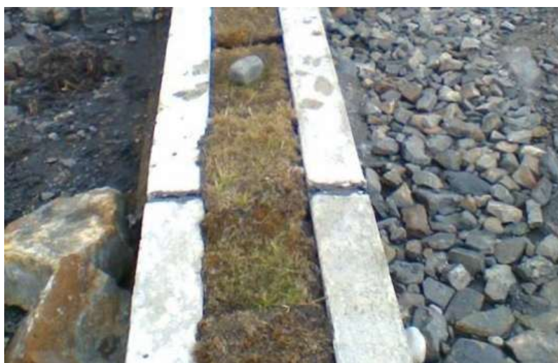
Imagen Nº 3: Canal de conducción de agua construido por el proyecto “Por las rutas del cambio climático”
