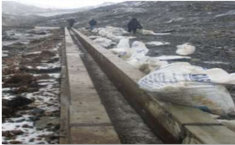
Imagen Nº 4: Limpieza concluida del canal
