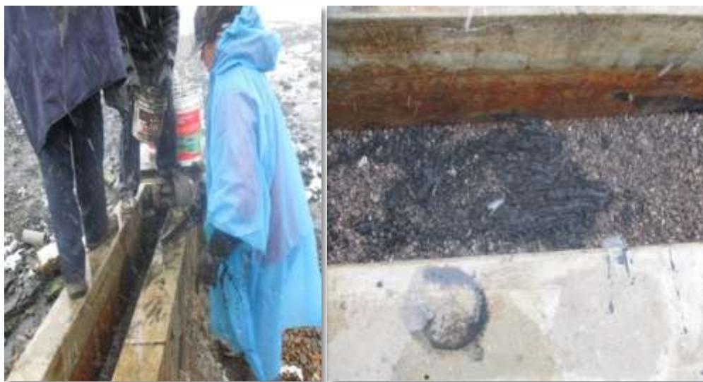
Imagen Nº 6: Adición de lodo activado portador de nutrientes y bacterias sulfato reductoras
