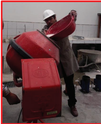
Fotografía 18: Adicionando el Aditivo Impermeabilizante a la Mezcla.
