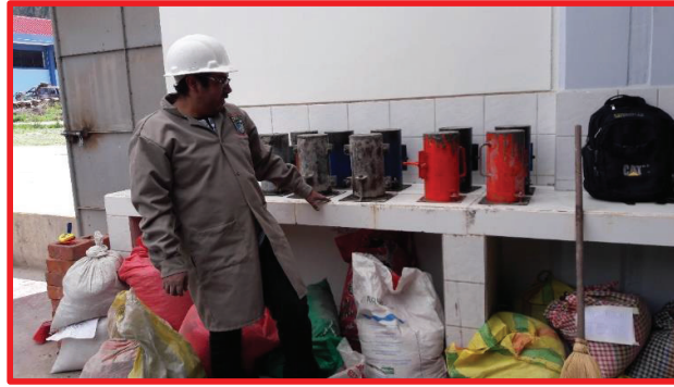
Fotografía 23: Terminado el vaciado se realizó el secado y fraguado del Concreto Armado.
