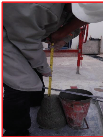
Fotografía 19: Determinando el Slump de la Mezcla de Concreto cumpliendo las 3 pulgadas requeridas según el ACI.
