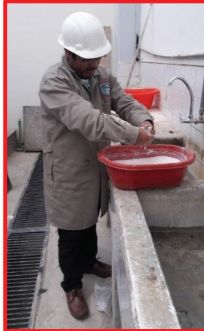
Fotografía 17: Preparación del Aditivo Impermeabilizante.
