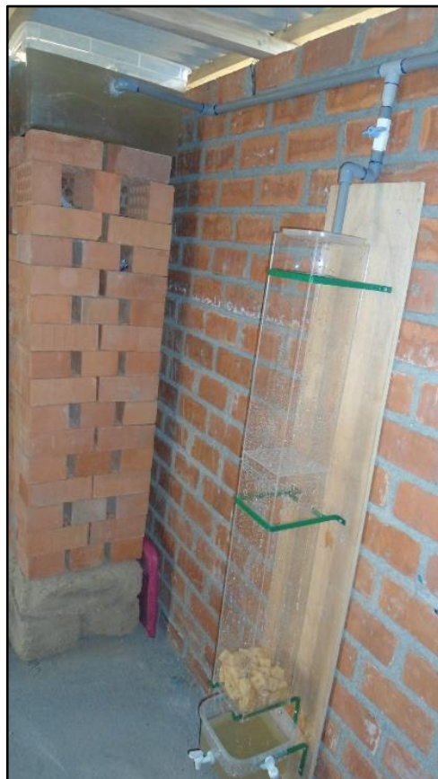
Figura 2.1.1. Estructura de soporte del reactor DHS-G6.
