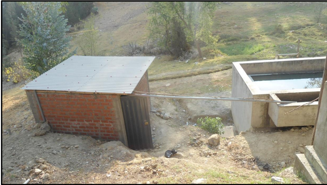
Figura 1.A: Ubicación de la caseta donde se instaló el reactor DHS.
