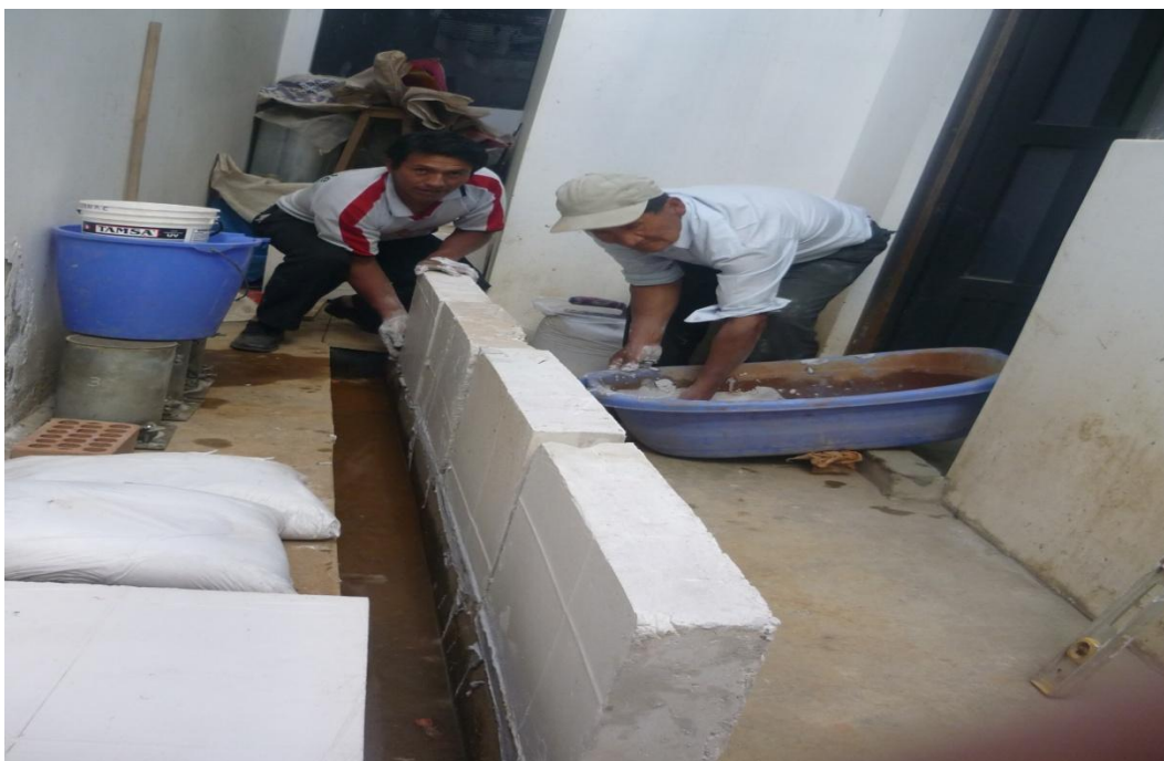
Construcción de pared con bloques de yeso de 9x40x60 cm Foto N° 27
