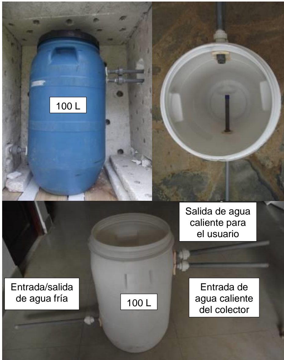
Fotografía: Tanques para almacenar agua caliente
