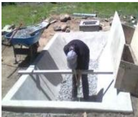
Fotografía 47: Verificando y nivelando las capas de los sustratos. Fuente. Trabajo de Campo.
