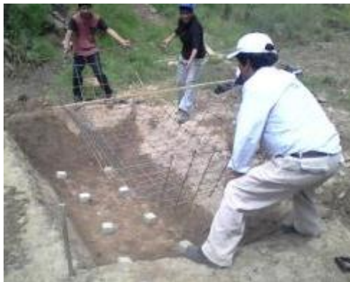
Fotografía 28: Colocación de la malla fijando los niveles con tacos de concreto. Fuente. Trabajo de Campo.
