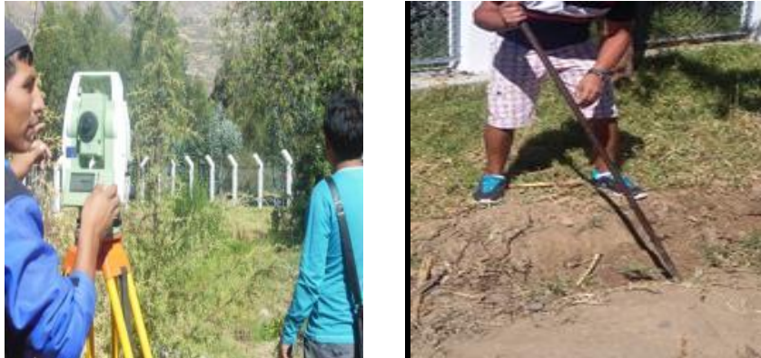
Fotografía 23: Levantamiento Topográfico y Prueba de Impermeabilidad. Fuente. Trabajo de Campo.
