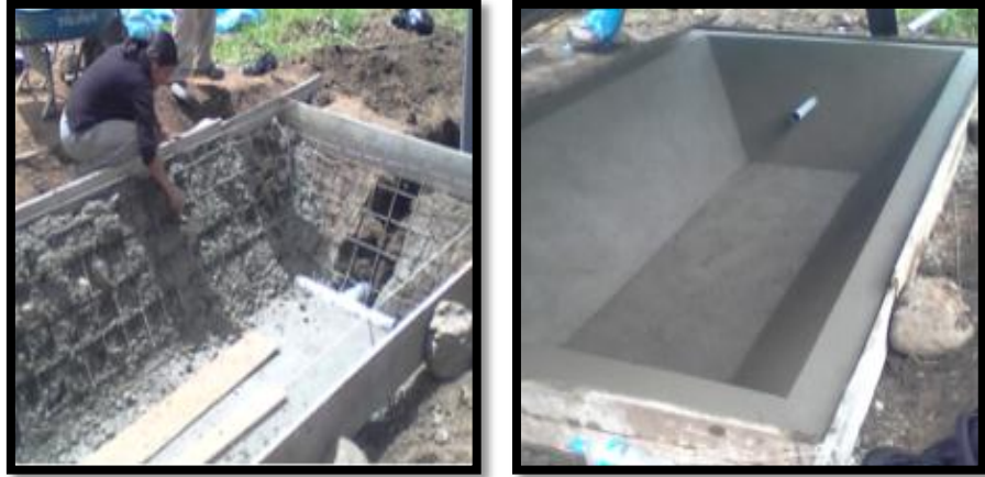
Fotografía 11: Vaciado de concreto en piso y pared del humedal con la instalación de tuberías de ingreso y salida.
