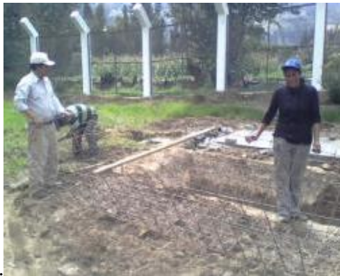
Fotografía 27: Habilitación y armado de la malla de fierro de 1/4 \" Fuente. Trabajo de Campo.
