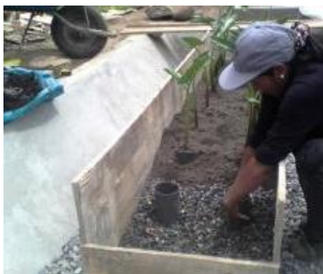
Fotografía 49: Siembra de la planta en el sustrato del humedal. Fuente. Trabajo de Campo.
