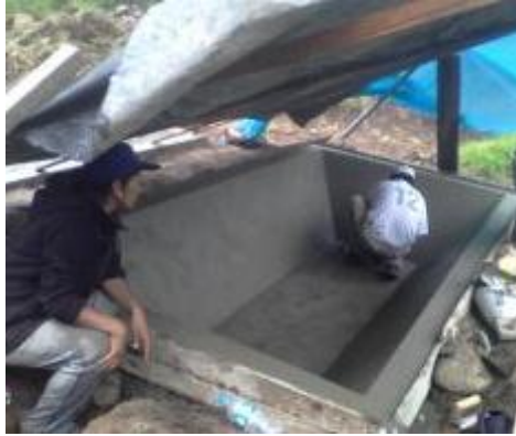
Fotografía 38: Frotachado de las paredes del humedal. Fuente. Trabajo de Campo.
