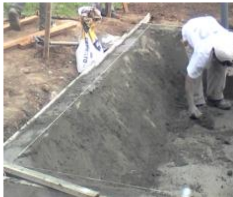
Fotografía 37: Tarrajeo de las paredes del humedal. Fuente. Trabajo de Campo.
