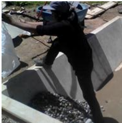
Fotografía 46: Llenado de la grava de 32 mm en la base del humedal y grava de 8 mm para la siembra de las plantas. Fuente. Trabajo de Campo.
