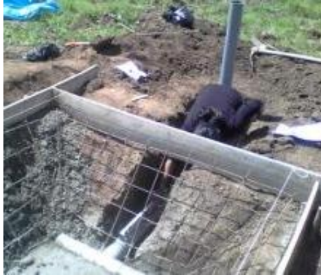
Fotografía 35: Verificación de la pendiente 1% para la evacuación del efluente. Fuente. Trabajo de Campo.
