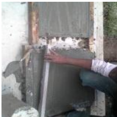
Fotografía 44; Armado de malla de fierro y encofrado de las tapas de la CDQ y la caja recolectora del efluente del humedal. .Fuente. Trabajo de Campo.
