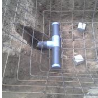
Fotografía 29: Habilitación e instalación de la tubería de 4" para la evacuación del efluente del humedal Fuente. Trabajo de Campo
