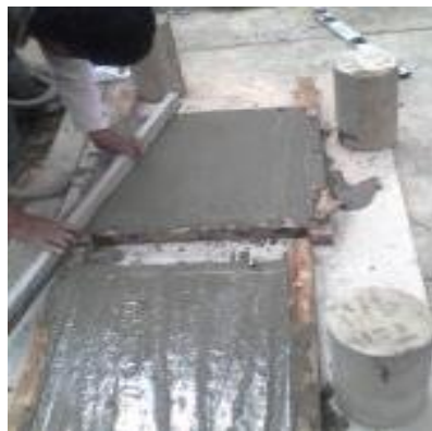
Fotografía 44; Armado de malla de fierro y encofrado de las tapas de la CDQ y la caja recolectora del efluente del humedal. .Fuente. Trabajo de Campo.
