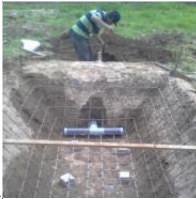
Fotografía 30: Excavación de la caja recolectora del caudal del efluente del humedal. Fuente. Trabajo de Campo.
