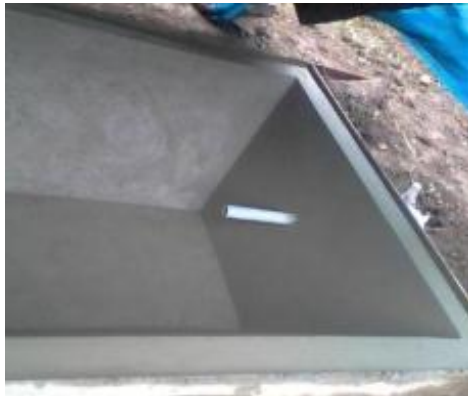
Fotografía 39 : Instalación de la tubería de ingreso de caudal al humedal. Fuente. Trabajo de Campo.
