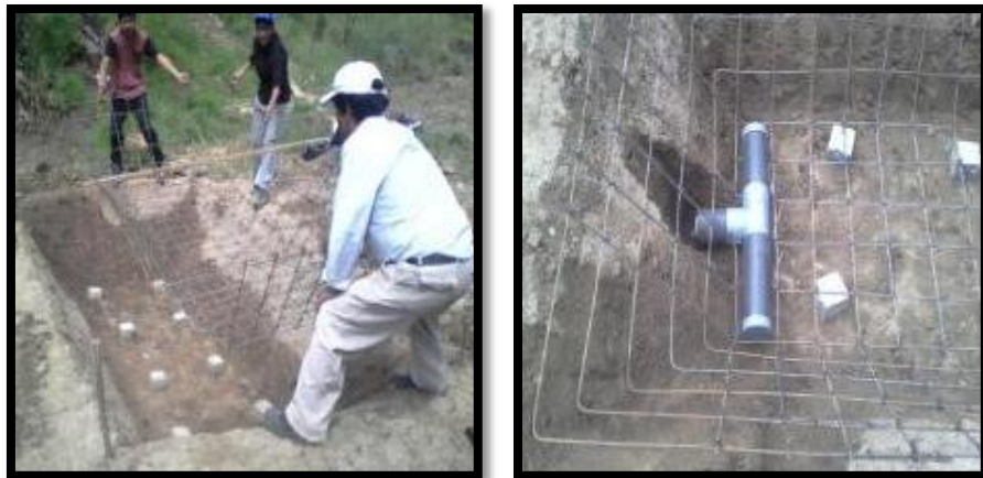
Fotografía 10: Habilitación e Instalación de acero de refuerzo y tuberías de evacuación del Humedal. Fuente. Trabajo de Campo.
