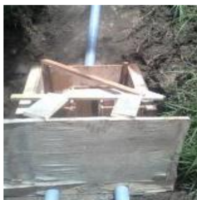
Fotografía 42:Habilitación e Instalación del enconrado interior de la Caja Distribuidora de caudal. Fuente. Trabajo de Campo.
