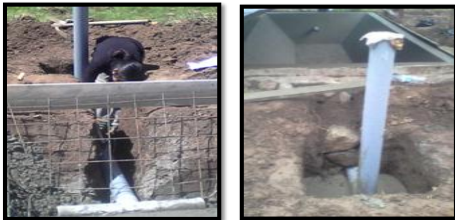
Fotografía 12: Construcción de la caja de recolección del efluente del humedal.
