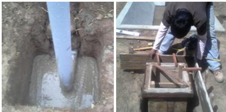
Fotografía 40; Vaciado de concreto en el piso y encofrado de la caja recolectora del efluente del humedal de flujo horizontal. Fuente. Trabajo de Campo.
