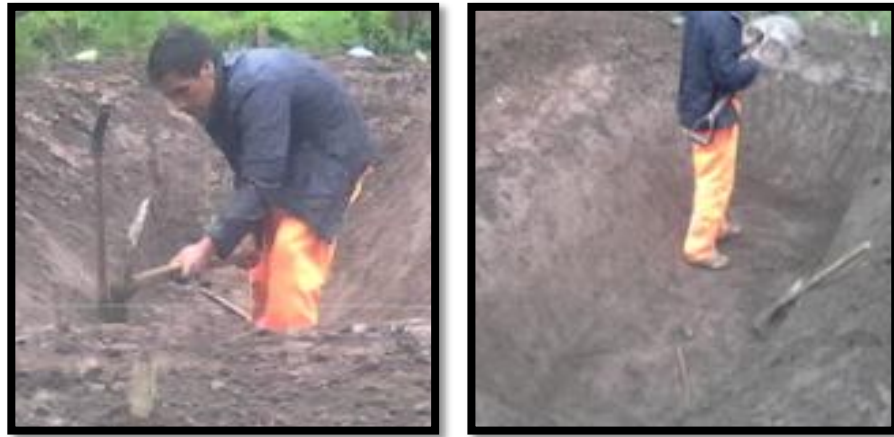
Fotografía 9 : Excavación y perfilado manual del humedal. Fuente. Trabajo de Campo.
