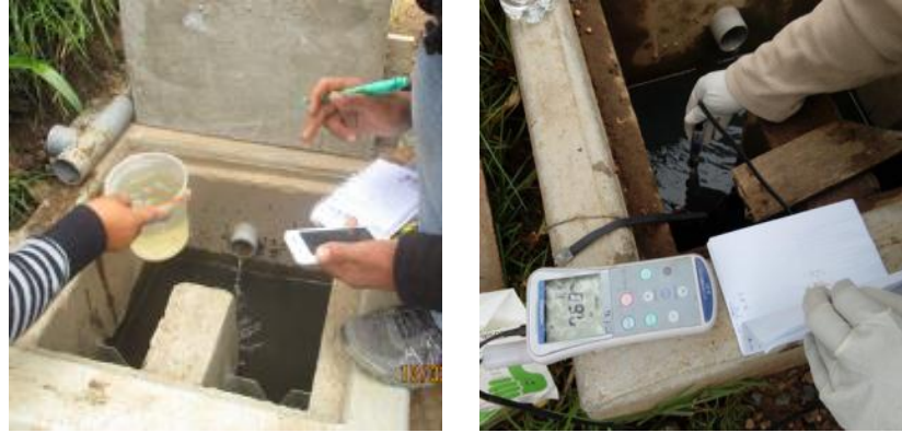
Fotografía 52: Aforo de caudal y medición del pH y temperatura. Fuente. Trabajo de Campo.
