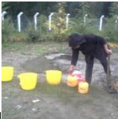
Fotografía 31: Preparación de la mezcla f'c=175 \text{ Kg/cm}^2 +sika para el piso y las paredes del humedal. Fuente. Trabajo de Campo.
