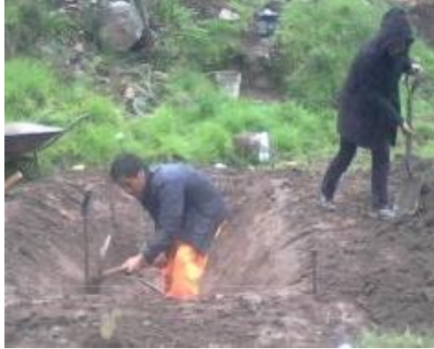
Fotografía 26: Excavación y vaciado de piso del humedal. Fuente. Trabajo de Campo
