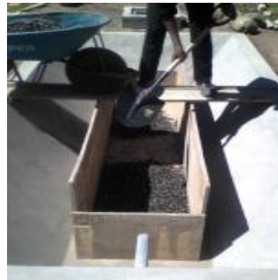
Fotografía 46: Llenado de la grava de 32 mm en la base del humedal y grava de 8 mm para la siembra de las plantas. Fuente. Trabajo de Campo.
