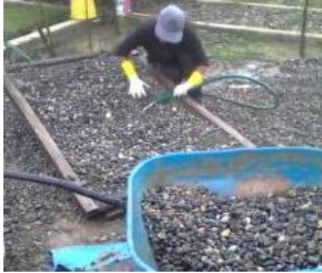
Fotografía 45: Habilitación de los sustratos para el humedal. Fuente. Trabajo de Campo.
