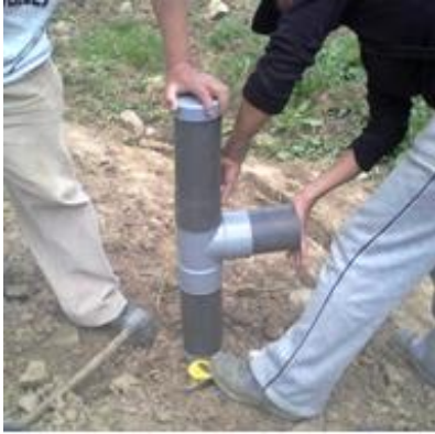
Fotografía 29: Habilitación e instalación de la tubería de 4" para la evacuación del efluente del humedal Fuente. Trabajo de Campo
