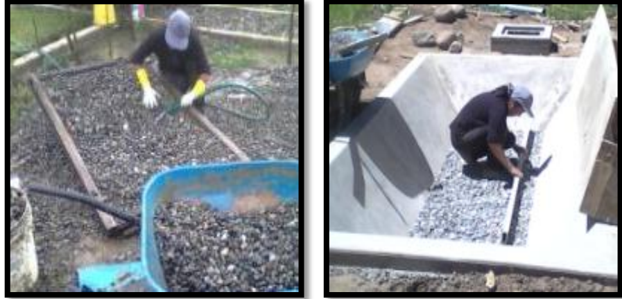
Fotografía 14: Habilitación y colocación del material granular en el humedal.
