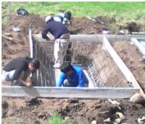
Fotografía 33 : Encofrado externo para la pared del humedal Fuente. Trabajo de Campo.
