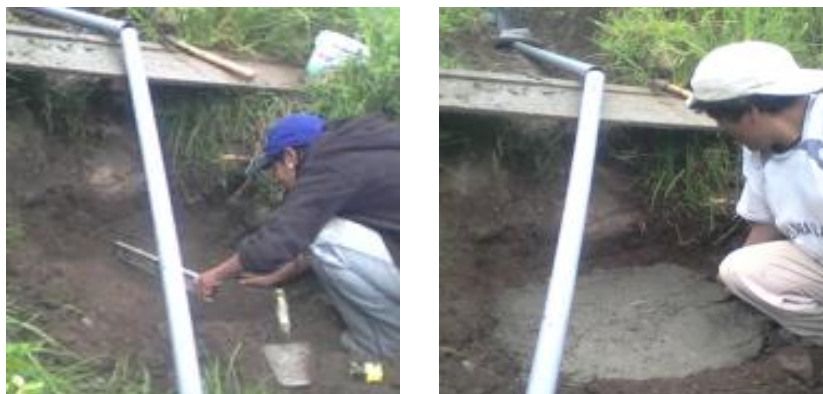
Fotografía 41 ;Excavación, nivelación y compactación y vaciado de concreto en el piso de la CDQ (caja distribuidora de caudal). Fuente. Trabajo de Campo.
