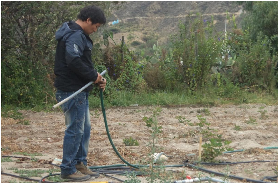
Figura D 2. Proceso de instalación del micro aspersor
