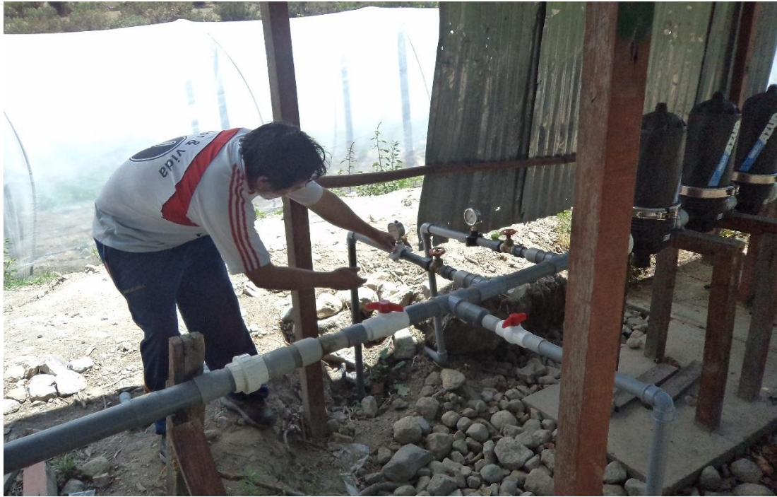
Figura D 5. Cabezal de riego
