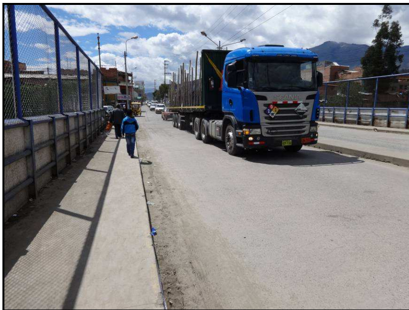
Foto B-02 : Servicio de la sub estructura y superestructura del puente.
