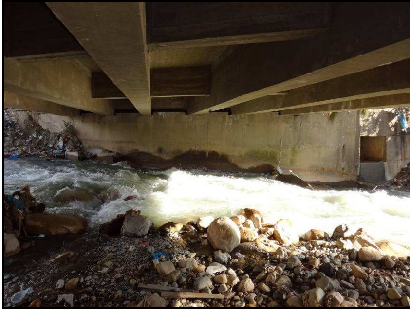
Foto CE-05 : Distribución de vigas principales, digas diafragma y dados de protección.
