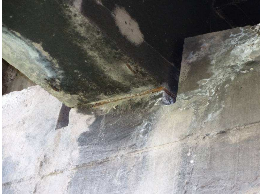
Foto B-11 : Apoyo de transmisión de esfuerzo entre viga principal y estribo de puente.
