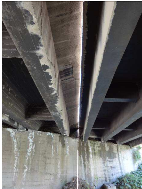
Foto B-10 : Se observa que no existe amortiguamiento en la unión de puentes, central con el lado oeste.
