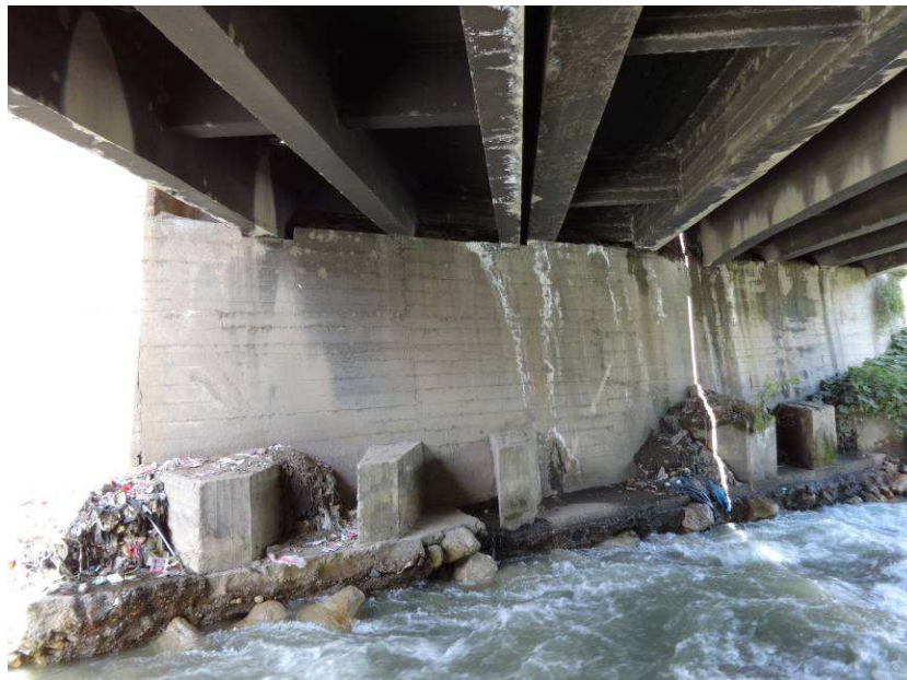
Foto B-06 : Superestructura principal compuesto por 03 unidades de puentes.
