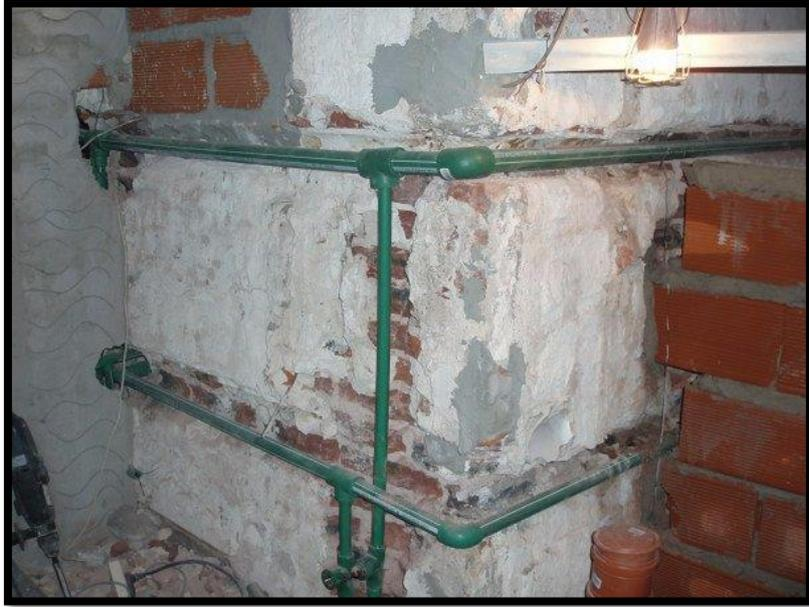
INSTALACIONES SANITARIAS EN BAÑO PARA AGUA FRIA CON TUBERIA DE POLIPROPILENO (PPR).
