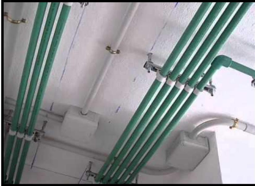
INSTALACIONES SANITARIAS EN TECHO DE UNA EDIFICACIONES PARA AGUA FRIA CON TUBERIA DE POLIPROPILENO (PPR).
