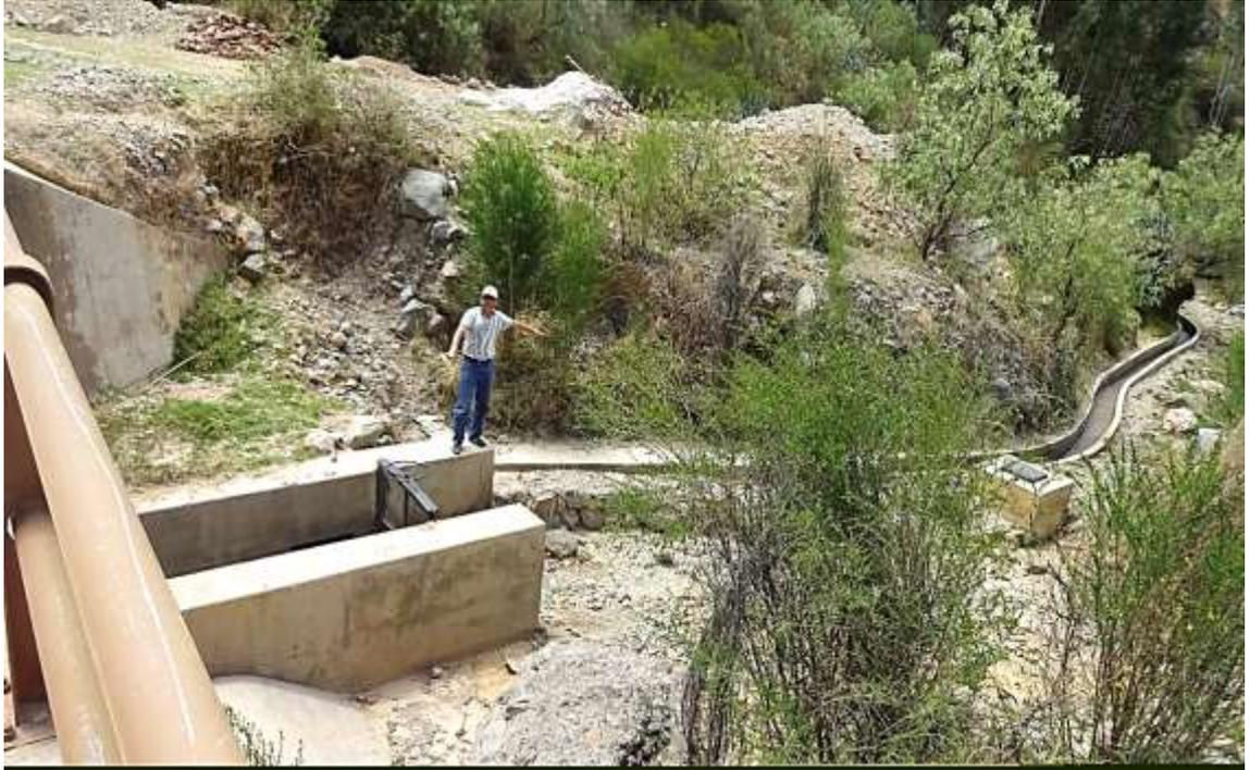
**FOTO 15:** Canal de regadío que se deriva del río Llacash, con escaso caudal de agua y que riega parcelas agrícolas de la parte baja de Jagua. En este lugar el agua es escasa y de mala calidad según refieren los agricultores.
