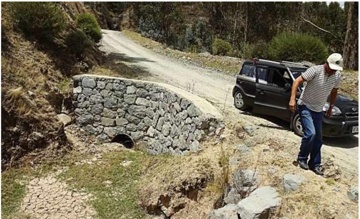
**FOTO 14:** Tubería de agua parcialmente tapada por falta de mantenimiento, que cruza la carretera a la altura de Huanja en la vertiente sur de la zona de estudio.
