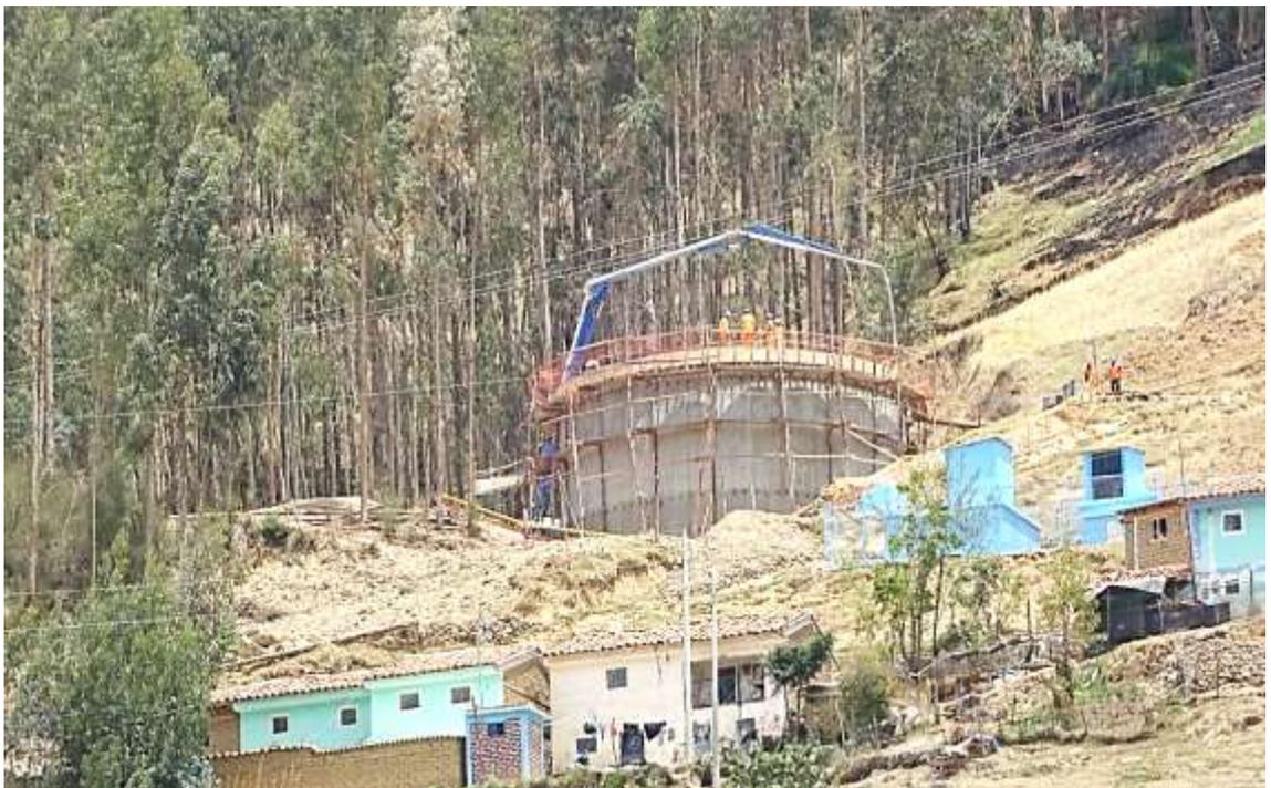
**FOTO 16:** Esta imagen data de inicios del 2017. Se aprecia el avance en la construcción del reservorio de agua potable ubicado en la parte alta de Mataquita que es el más grande de la zona de estudio. Actualmente se encuentra operativo, pero con caudal reducido y no da solución al problema de gestión integral del agua.
