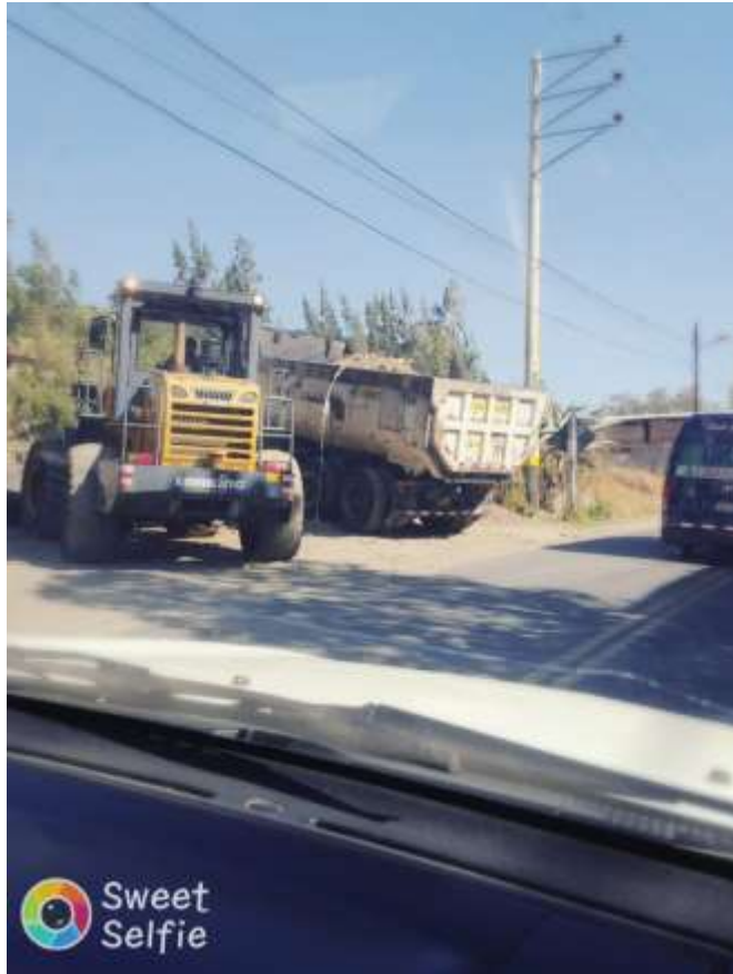
Figura 22: Vehículo recolector y cargador frontal realizando trabajos recolección de RCD.
