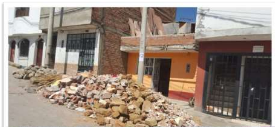
Figura 20: Puntos de acumulación de RCD
