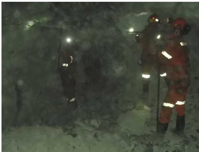
FOTOGRAFÍA N° 4: ACUÑADURA DE ROCAS, EN LA PROLONGACIÓN DE LA RAMPA PRINCIPAL
