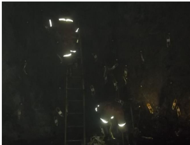
FOTOGRAFÍA N° 2: MUESTRA EL CARGUÍO DE DE LA GALERÍA 13-SUR ANTES DE LA TRONADURA
