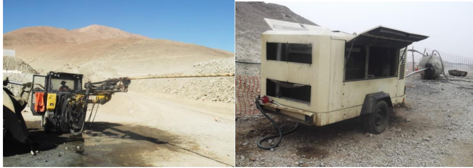
FOTOGRAFÍA N° 1: JUMBO BOOMER Y COMPRESOR PARA LA PERFORADORA MANUAL
