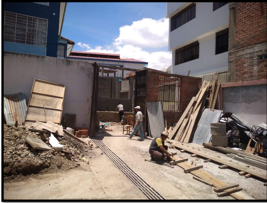
FOTOGRAFIA 14: ETAPA DE CONSTRUCCION DEL DEPOSITO DE RESIDUOS PELIGROSOS
