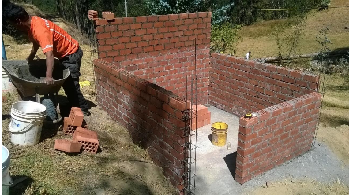
Fotografía N° 24: Construcción de la caseta en la PTAR C.P. Marián
