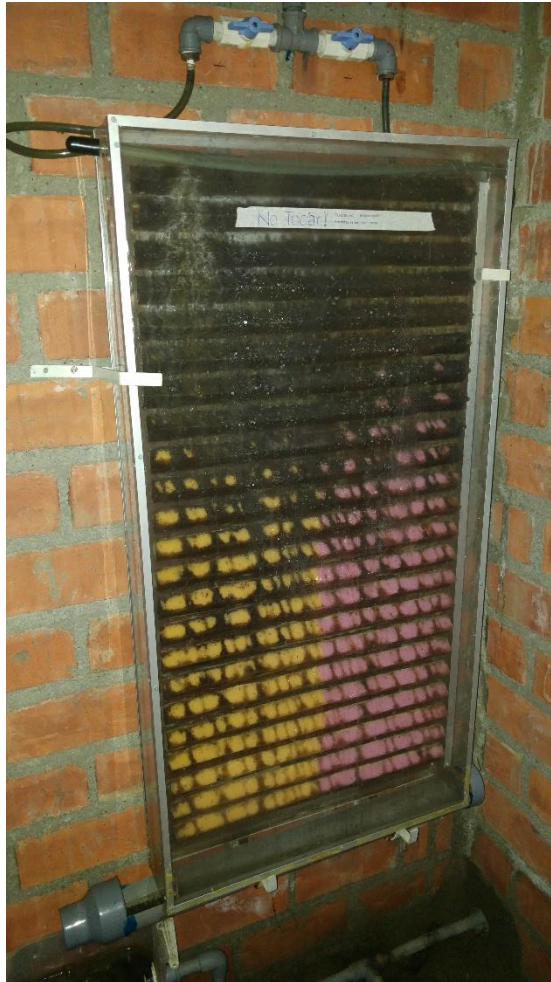
Fotografía N° 36: Proceso intermedio del tratamiento
