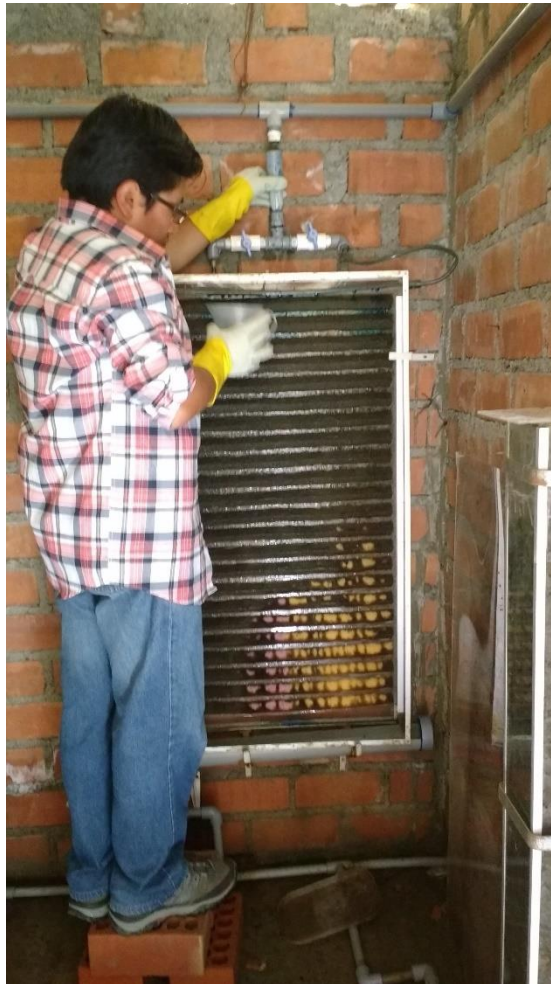
Fotografía N° 43: Limpieza en el sistema de distribución del caudal
