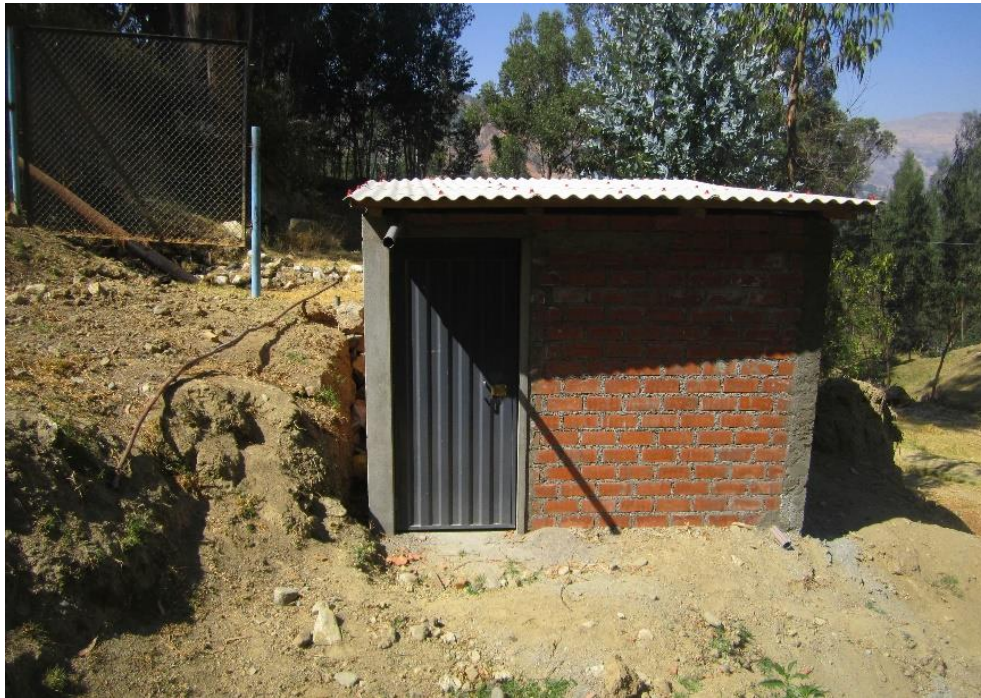
Fotografía N° 2: Caseta de protección
