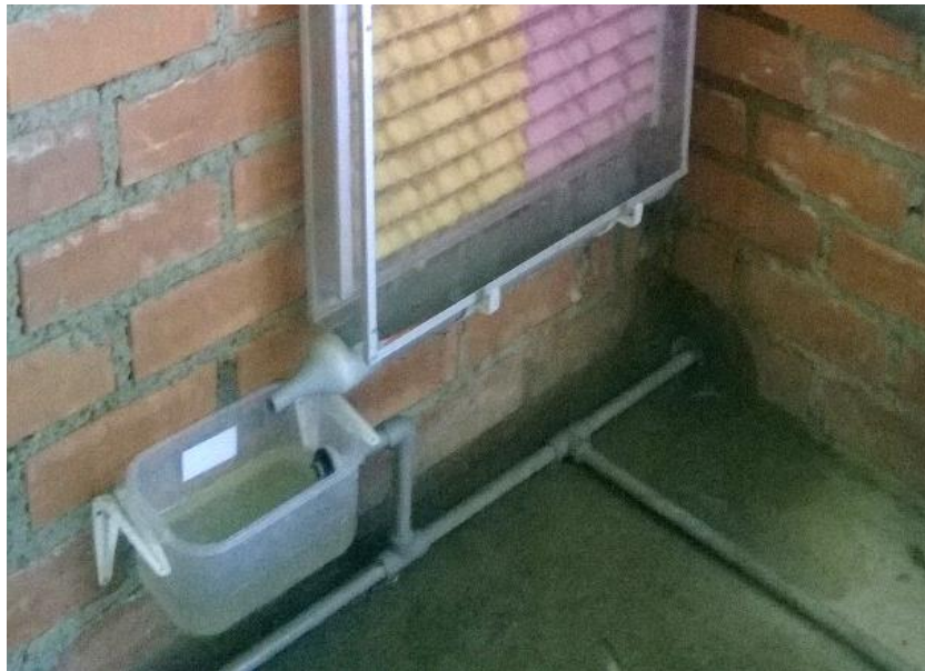
Fotografía N° 10: Recolección del efluente
