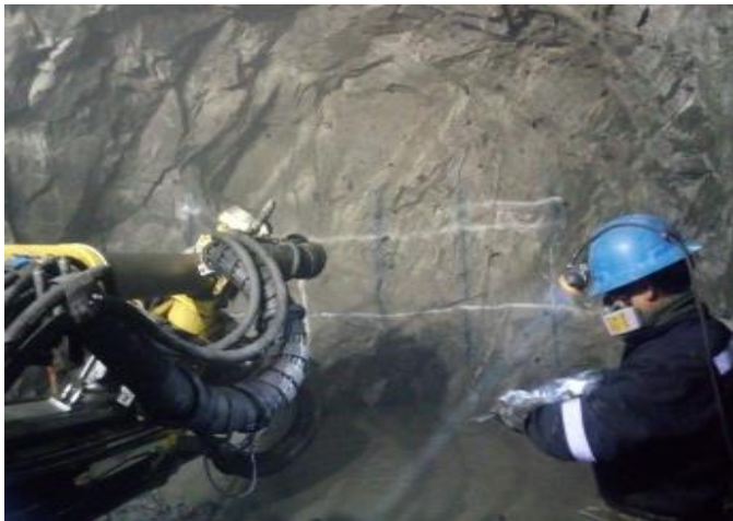
Seguimiento de la perforación en la Rampa (+) 995 Nivel 2A.
