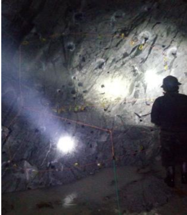
Carguío de taladros en la Rampa (+) 995 del Nivel 2A.
