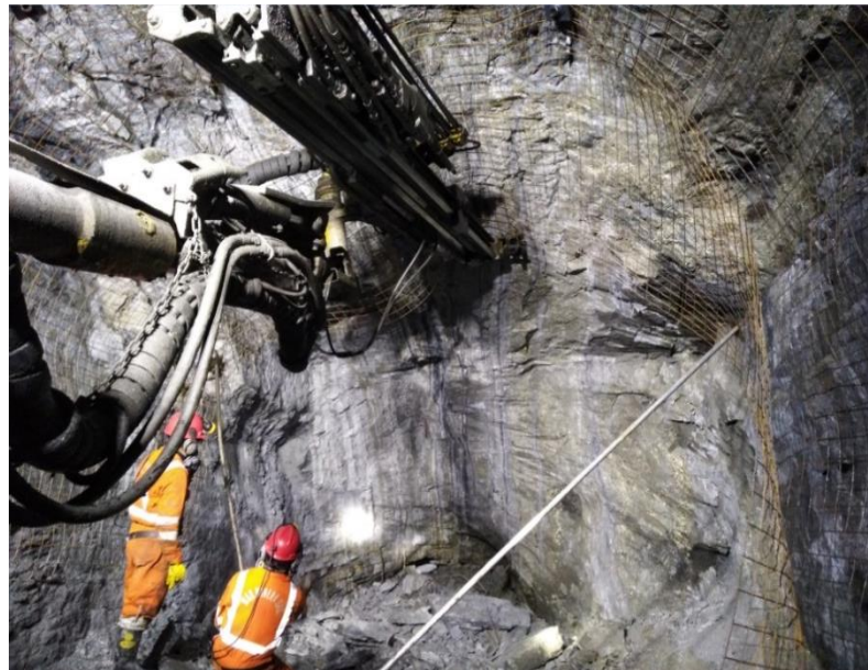
Fotografía N°09 , Sujeción de la malla en hastiales
