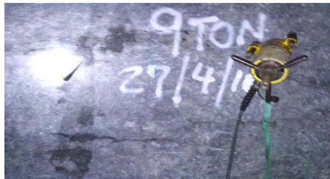
Fotografía N°14 , Pruebas de Tracción U-80 veta 4
