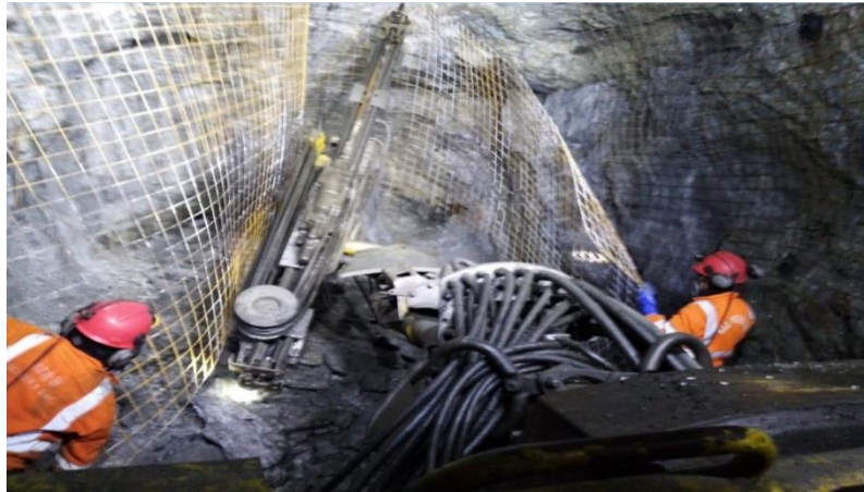
Fotografía N°08 , Presentación de malla en la roca
