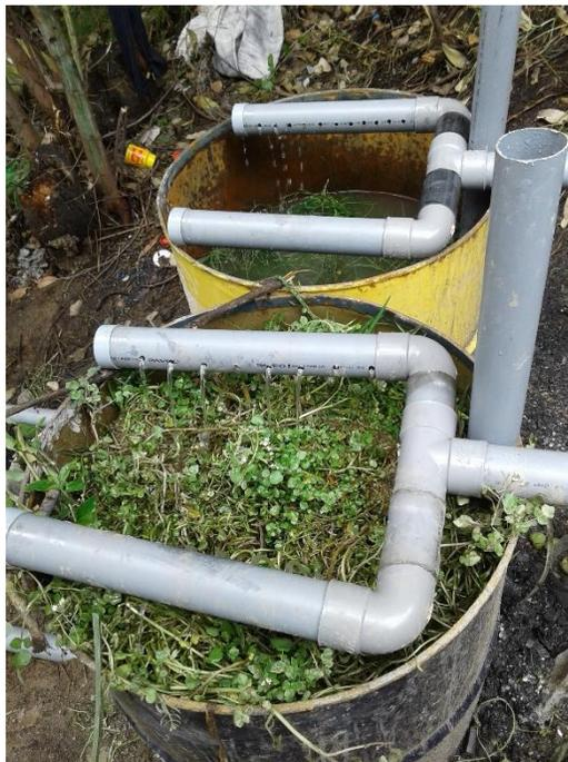
**FOTOGRAFÍA 31: SISTEMA COMPLETO DEL HUMEDAL ARTIFICIAL DE FLUJO VERTICAL DOS BATERIAS CON TRES TANQUES CADA UNO**
