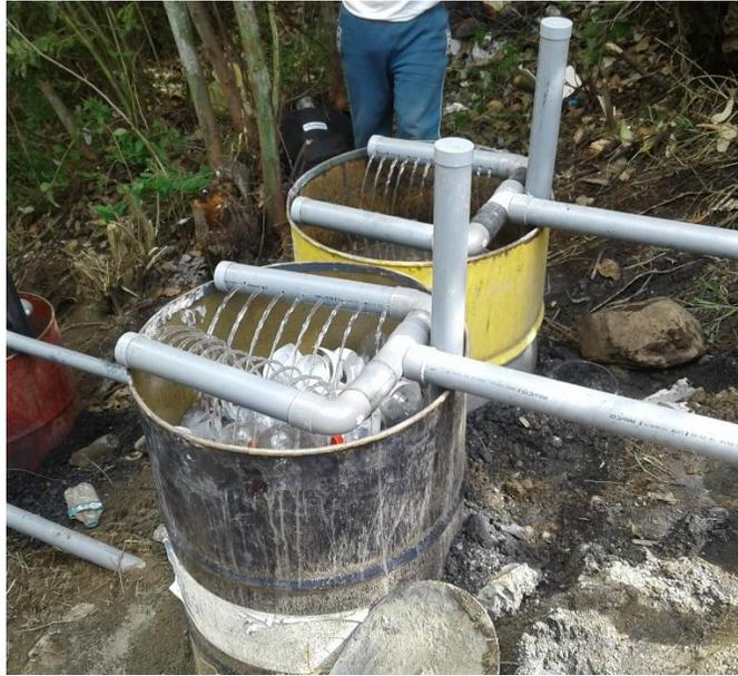
**FOTOGRAFÍA 30: FUNCIONAMIENTO DEL HUMEDAL ARTIFICIAL DE FLUJO VERTICAL**
