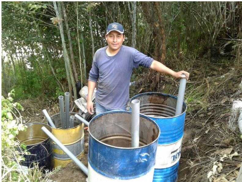
**FOTOGRAFÍA 25: COLOCACIÓN DE LA GRAVA EN LA BASE DEL TANQUE**
