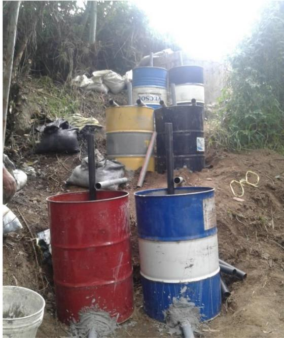
**FOTOGRAFÍA 28: INSTALACIÓN DEL SISTEMA DE DISTRIBUCIÓN DEL AGUA RESIDUAL DE LA LOCALIDAD DE TOMA**
