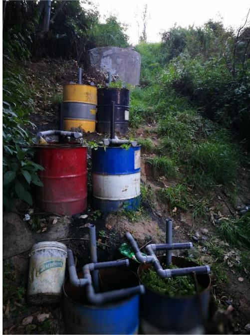
**FOTOGRAFÍA 32: TOMA DE MUESTRA EN LA ENTRA DEL HUMEDAL ARTIFICIAL DE FLUJO VERTICAL**
