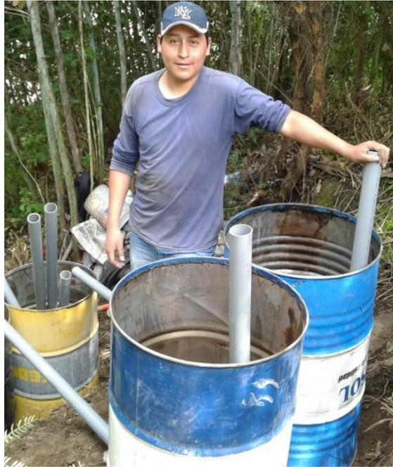
**FOTOGRAFÍA 7: INSTALACIÓN DE LA TUBERÍA DE VENTILACIÓN PARA EL SUSTRATO**
