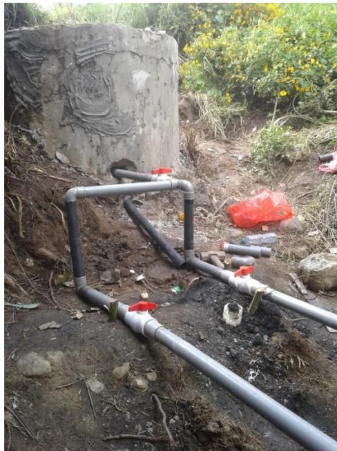
5. Se instala los tanques uno para cada serie y luego se procede a la instalación de la tubería de ventilación para el sustrato como se observa en la fotografía 6 y 7.
