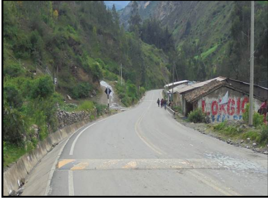
Fotografía 47. En el Km 61+260, ingreso a la vía de estudio con posibilidad de viraje a la izquierda, advertida por la presencia de gibas antes y después del ingreso.
