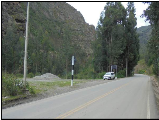
Fotografía 59. En el Km 61+060, presencia un soporte vertical, puntos duros y agregados en la zona de despeje lateral.
