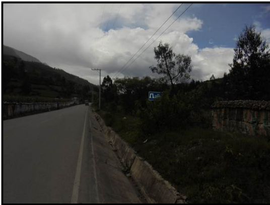
Fotografía 43. En el Km 68+900, vegetación impide la lectura de señal vertical (señal informativa).
