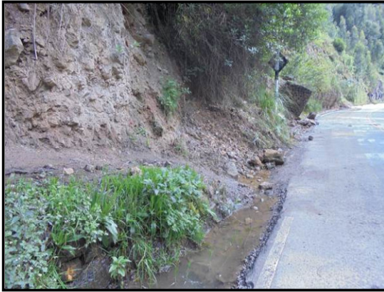
Fotografía 01. Acceso en Km 61+620, destinado a los peatones que solo es adecuadamente visible (40m), en un solo sentido (Chavín de Huántar – Machac).
