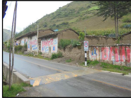
Fotografía 50. En el Km 63+400, giba al ingreso a la localidad de Quercos, controlando así la velocidad de los vehículos.
