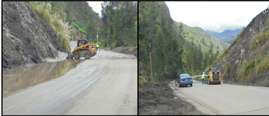
Figura 10: Trabajos de Mantenimiento en la Vía.
