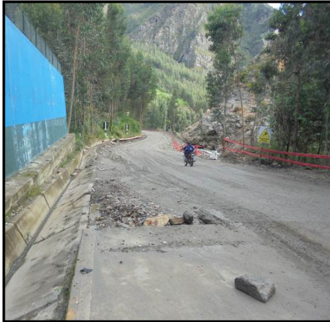
Fotografía 09. Desde el Km 60+540 hasta el Km 60+780, existe evidencia del deslizamiento del terraplén, lo que condujo a la fractura de la vía (calzada, berma y ambas cunetas), situación que hace ahora que la calzada no esté adecuadamente definida.
