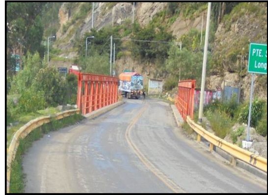
Fotografía 30. En el Km 73+890 se ubica el puente “San Marcos”, de 30m de longitud, compatible con el ancho de la vía, veredas de 50cm de ancho (75cm ancho mínimo)
