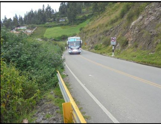
Fotografía 21. En el Km 66+380, se puede ver que la vegetación actualmente a cubierto gran parte de la barrera de contención y estaría afectando también al carril contiguo de la calzada.
