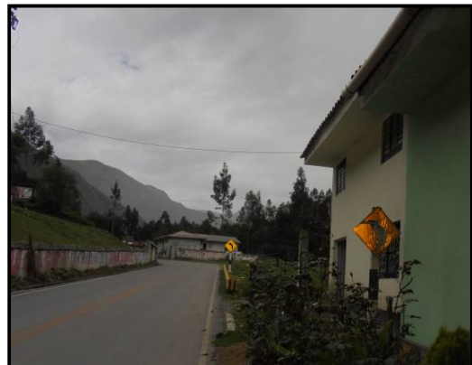
Fotografía 20. En el Km 66+780, se advierte la presencia de una señal vertical antigua que no se retiró cuando se realizó la instalación de las nuevas señalizaciones.
