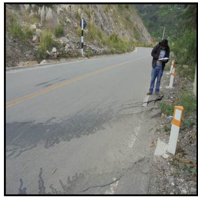
Fotografía 18. Entre el Km 70+900 y Km 71+340, sector que congrega gran cantidad de fisuras (longitudinales y transversales a la vía) que han sido tratadas, todas ellas generadas por la erosión que viene sufriendo el terraplén por parte del Rio Mosna, lo que se traduce en asentamientos diferenciales que propician estas fracturas.
