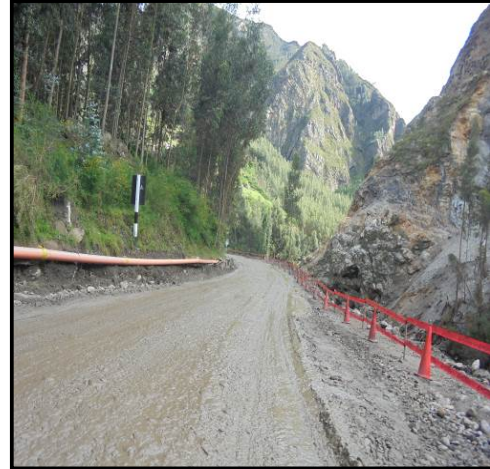
Fotografía 09. Desde el Km 60+540 hasta el Km 60+780, existe evidencia del deslizamiento del terraplén, lo que condujo a la fractura de la vía (calzada, berma y ambas cunetas), situación que hace ahora que la calzada no esté adecuadamente definida.
