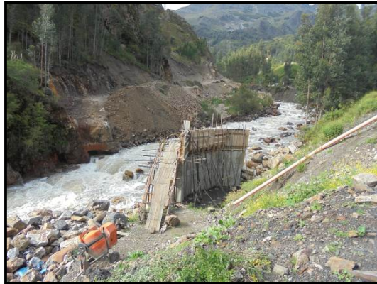
Fotografía 72. En el Km 60+900, presencia de trabajos de construcción de defensa ribereña.
