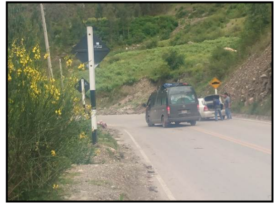
Fotografía 32. En el Km 61+250, vehículo detenido en la calzada por no existir presencia de bermas.
