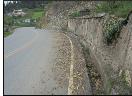
Fotografía 04. La vía presenta una contracurva sin considerar una longitud mínima de 42m como lo indica DG-2018, no se advierte presencia de señales verticales ni horizontales.
