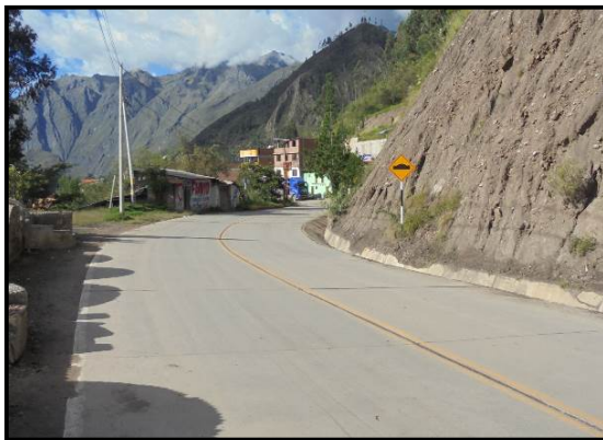
Fotografía 55. Entre el Km 74+100 al Km 75+160, presencia de la línea de borde solo a un lado de la calzada.
