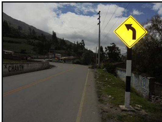
Fotografía 05. Entre los Km 69+200 y Km 69+240, la vía presenta una contracurva sin considerar un mínimo de 42m como lo indica DG-2018 además de no usar la señal adecuada.
