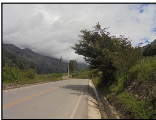
Fotografía 22. En el Km 69+750, presencia de un árbol que está sobre la calzada a una altura que afecta el libre flujo de vehículos grandes por el carril contiguo.
