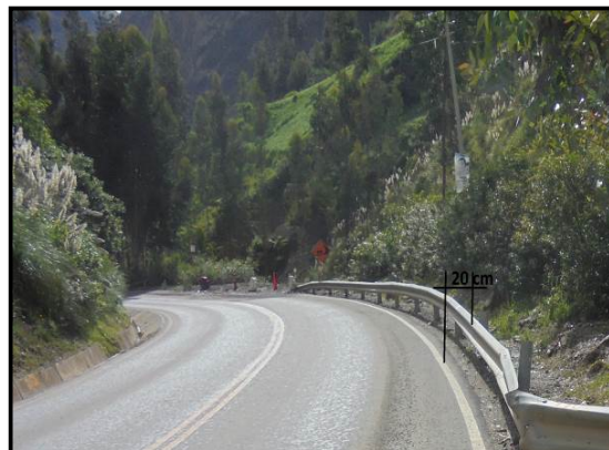
Fotografía 62. En el Km 61+470, el espacio entre la línea de borde y la barrera de contención solo es de 20cm lo que impide que un vehículo (aun un vehículo pequeño) pueda ser albergado en este espacio pequeño.
