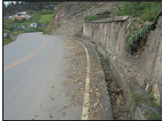
Fotografía 02. Acceso en Km 66+340, destinado al tránsito peatonal que solo es adecuadamente visible (65m), en un solo sentido (Machac – Chavín de Huántar).
