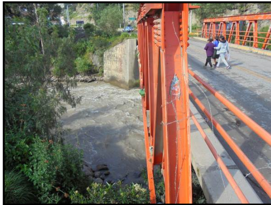
Fotografía 31. El puente “San Marcos”, cruza perpendicularmente al Rio Mosna, usando la distancia requerida.
