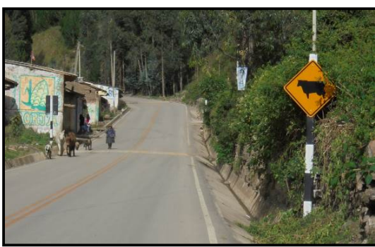
Fotografía 76. En el Km 61+280, presencia de animales domésticos en la calzada y señal vertical que indica la presencia de animales.
