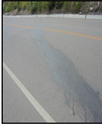
Fotografía 18. Entre el Km 70+900 y Km 71+340, sector que congrega gran cantidad de fisuras (longitudinales y transversales a la vía) que han sido tratadas, todas ellas generadas por la erosión que viene sufriendo el terraplén por parte del Rio Mosna, lo que se traduce en asentamientos diferenciales que propician estas fracturas.
