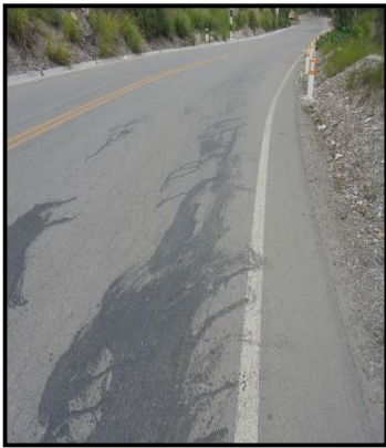
Fotografía 18. Entre el Km 70+900 y Km 71+340, sector que congrega gran cantidad de fisuras (longitudinales y transversales a la vía) que han sido tratadas, todas ellas generadas por la erosión que viene sufriendo el terraplén por parte del Rio Mosna, lo que se traduce en asentamientos diferenciales que propician estas fracturas.
