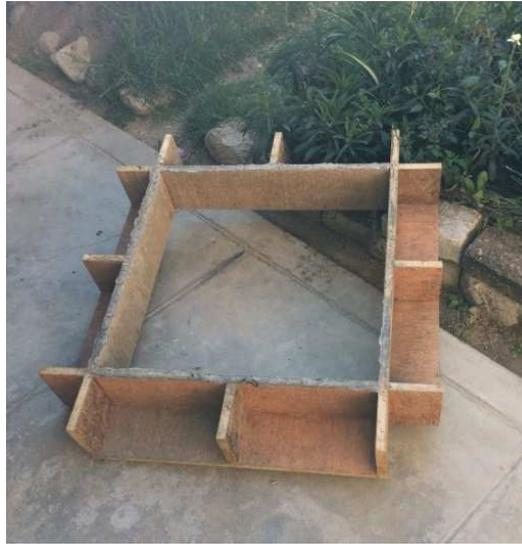
*Figura 24:* Encofrado usado para la fabricación de losas de prueba de concreto permeable.
