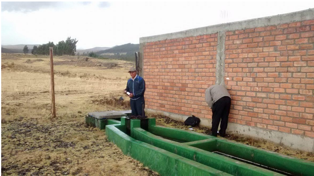
Figura 9: Ingreso del agua a los filtros
