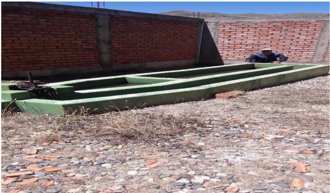
Figura 13: Vista del desarenador
